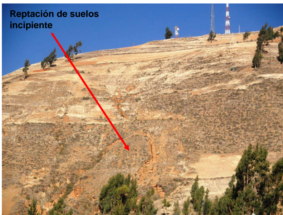
Foto 9. Proceso incipiente de reptación de suelos, que puede desencadenar en pequeños derrumbes o deslizamientos debido a la erosión y profundización de las cárcavas adyacentes.
