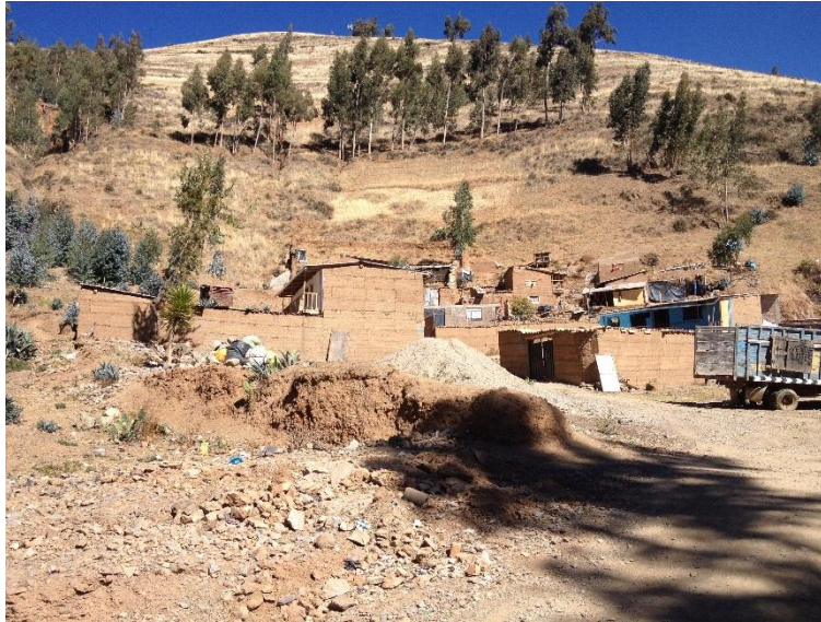
Foto 10. Viviendas construidas en la zona de alto riesgo por deslizamientos
