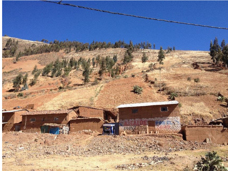
Foto 12. Ubicación de viviendas en las laderas, se observa la parte terminal en forma de surcos originado por la erosión en cárcavas.
