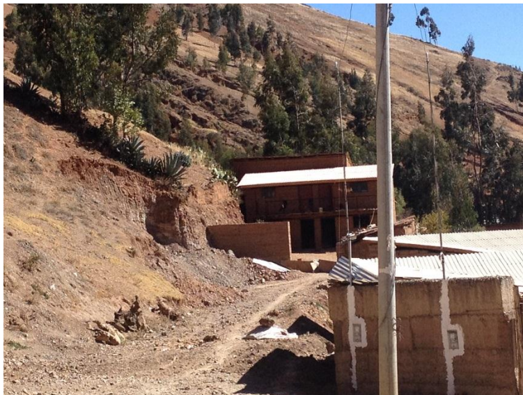
Foto 11. Construcciones hechas cortando el talud.
