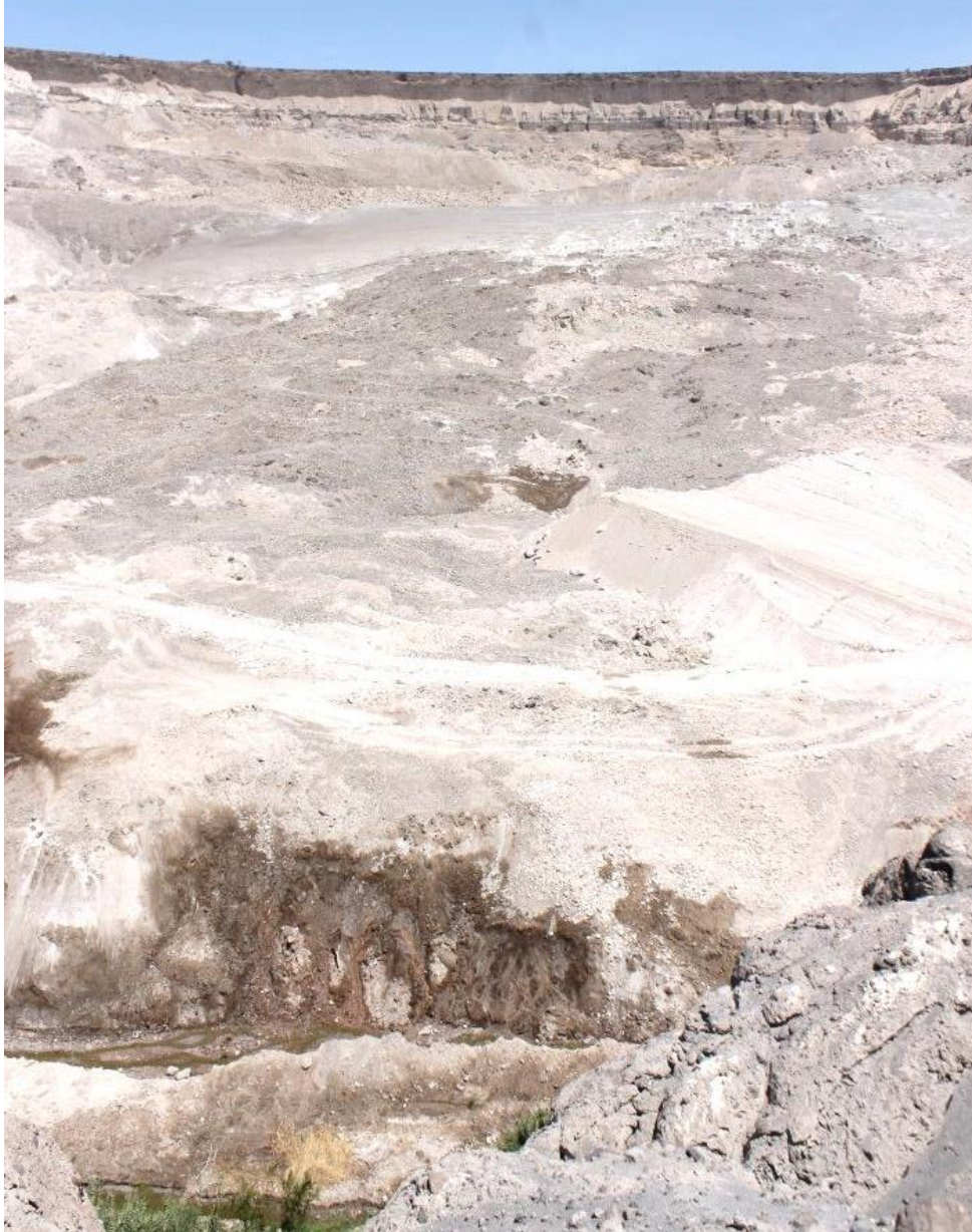
Foto 17: La masa del pie del deslizamiento afecta áreas del piso de valle. Presencia de filtraciones
