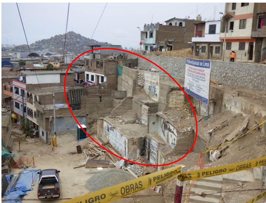
Foto 6. Lugar donde se ubicaban las viviendas afectadas en el 2003.
