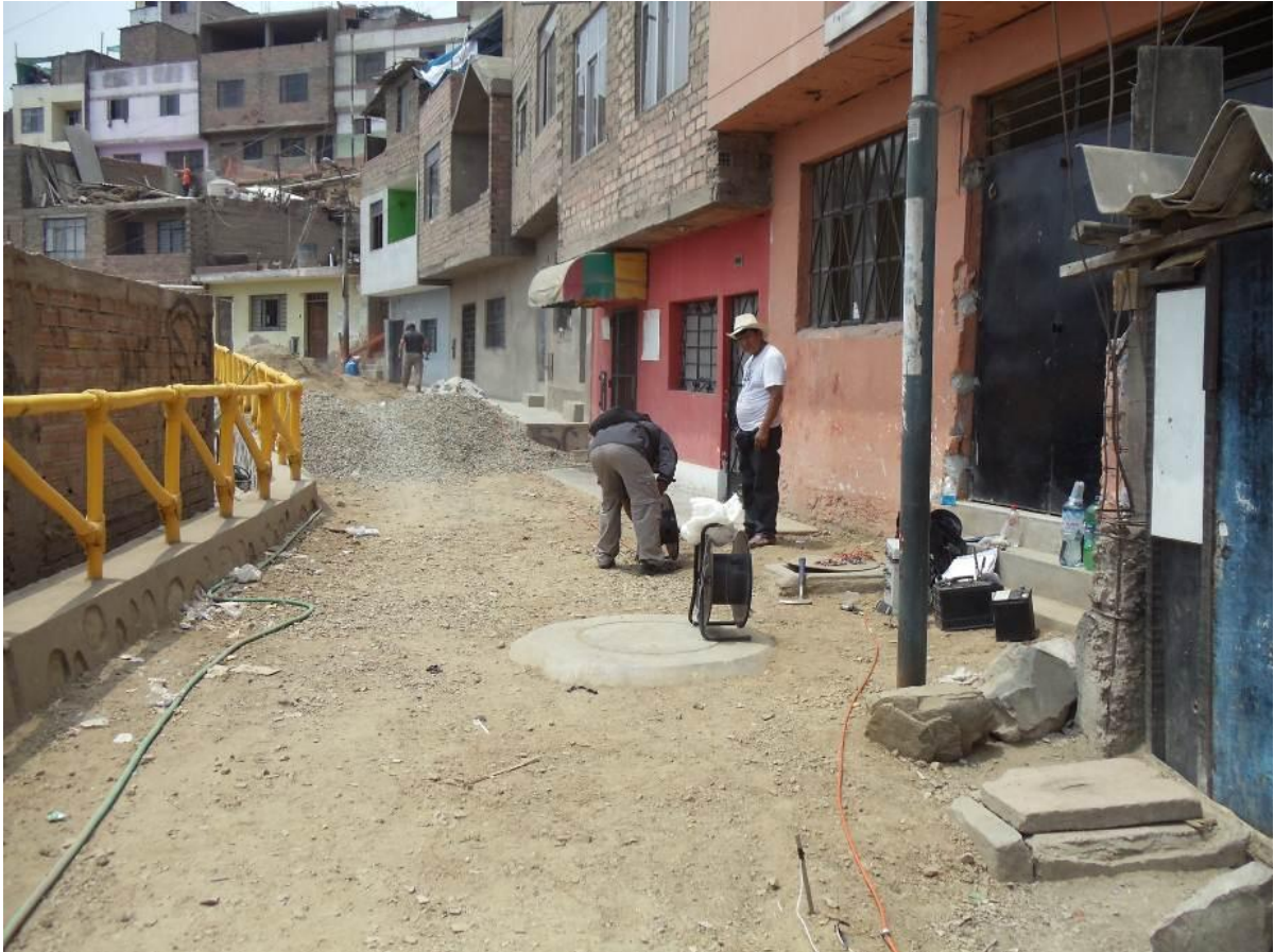
Foto 11. Se aprecia el tendido de la línea de Tomografía LT-01 en el Pasaje Alfonso Ugarte en el tramo de los electrodos del 24 a 48 puntos.
