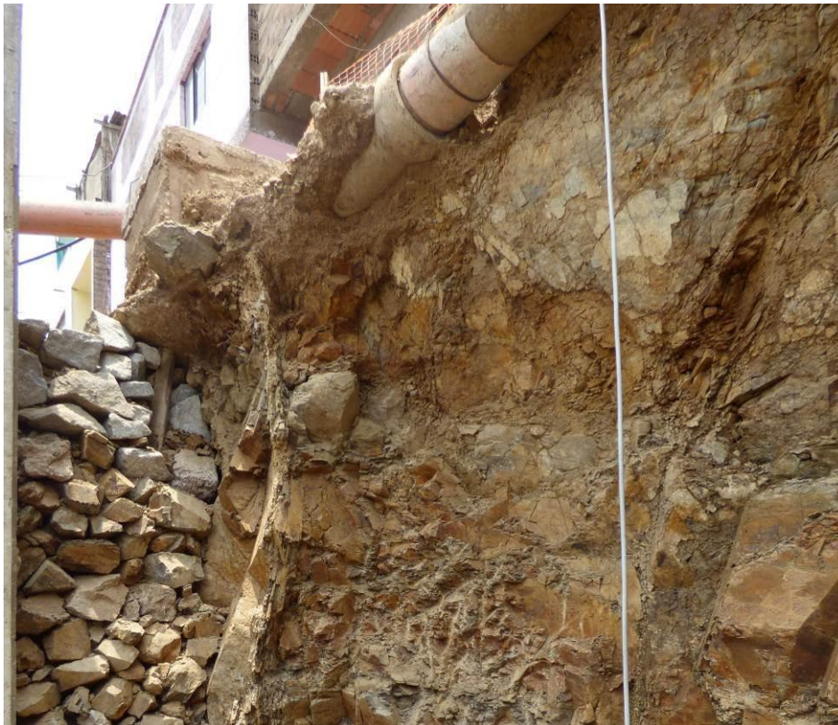
Foto 9. Roca poco a medianamente fracturada. Se muestra ligeramente a moderadamente meteorizada. Hacia la parte superior se observa una tubería de desagüe
