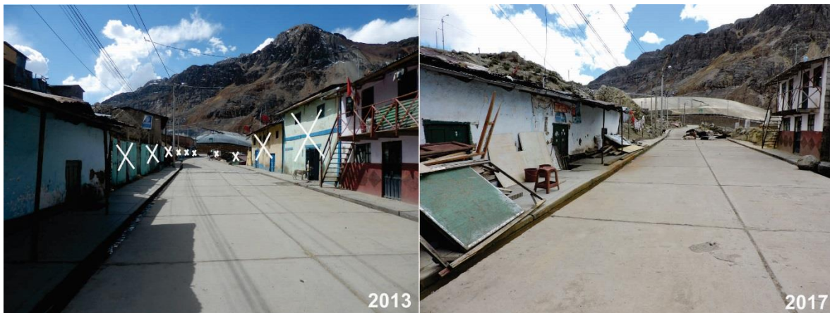
Foto 8. Al fondo de la calle Alejandría (Morococha) se observa con una "x" las viviendas demolidas al 2017.
