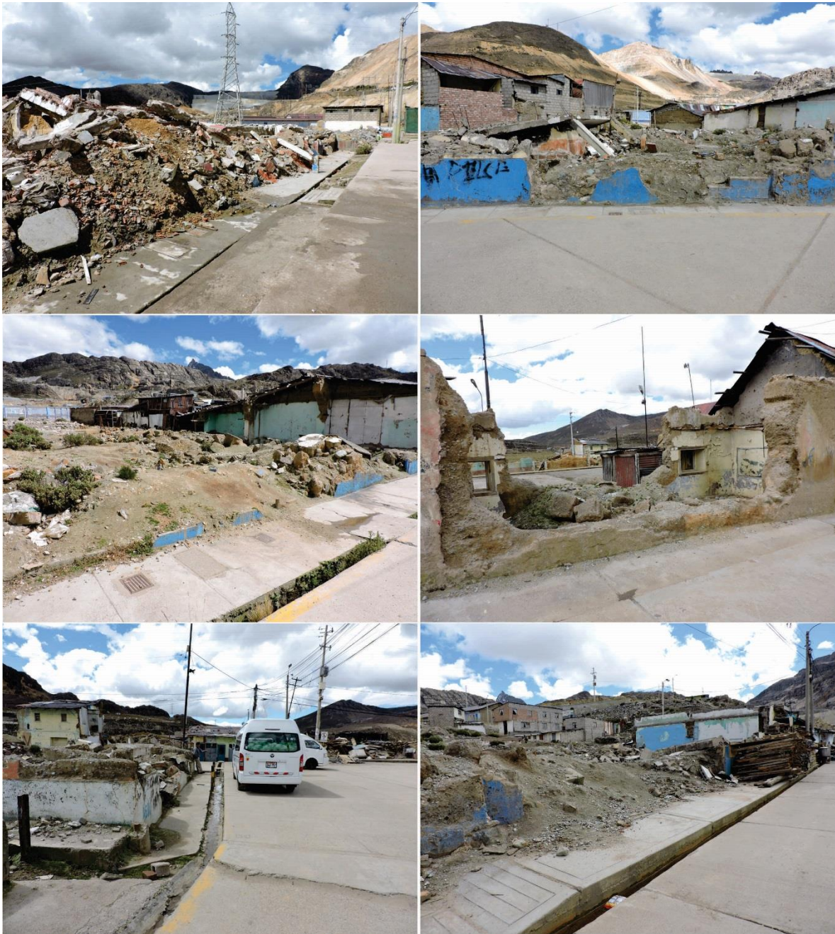
Foto 4. Acumulación de gran material de demolición en una gran parte del pueblo de Morococha, en la calle principal Pflucker, dan la apariencia de una ciudad abandonada.
