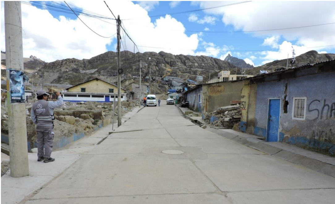
Foto 5. Numerosas viviendas demolidas en la intersección de las calles Pflucker y Llankee Bajo, sector Morococha antigua.
