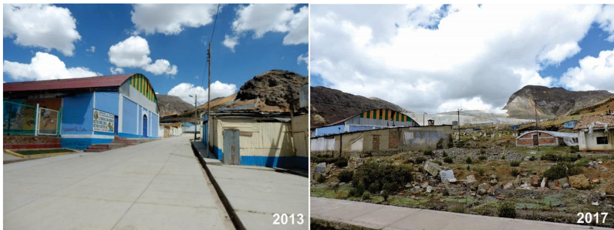
Foto 3. Viviendas demolidas en el sector Morococha Nueva, entre el Jr. Bolognesi y la ex Carretera Central.
