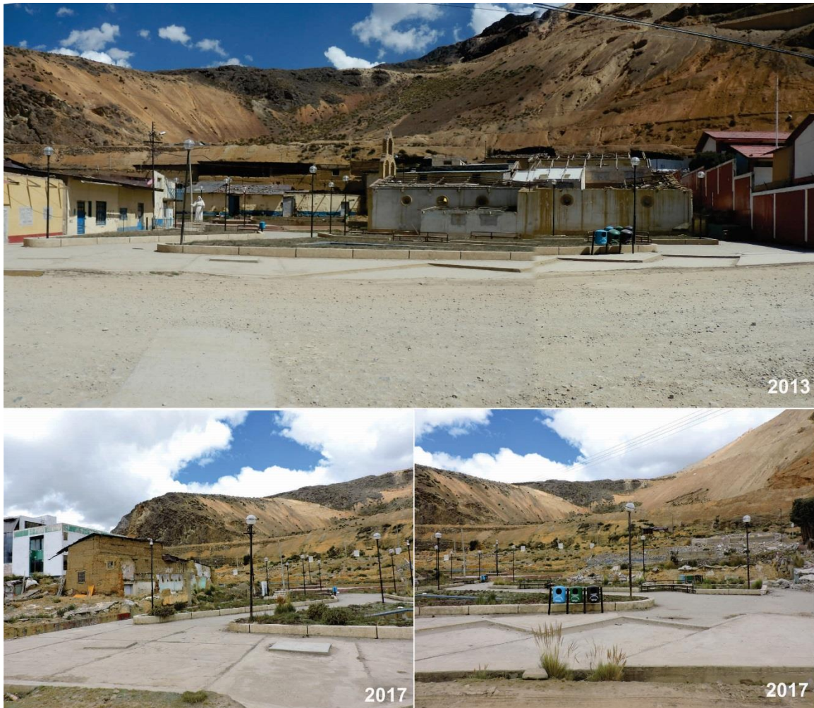
Foto 1. En el 2013 se observa las viviendas expuestas a caída de detritos o derrumbes y flujos en época de lluvias. En el 2017, estas viviendas ya se encuentran demolidas en el Jr. Comercio y la ex Carretera Central al costado del ex colegio, sector Morococha Nueva, al fondo se observa el cerro Toromocho.
