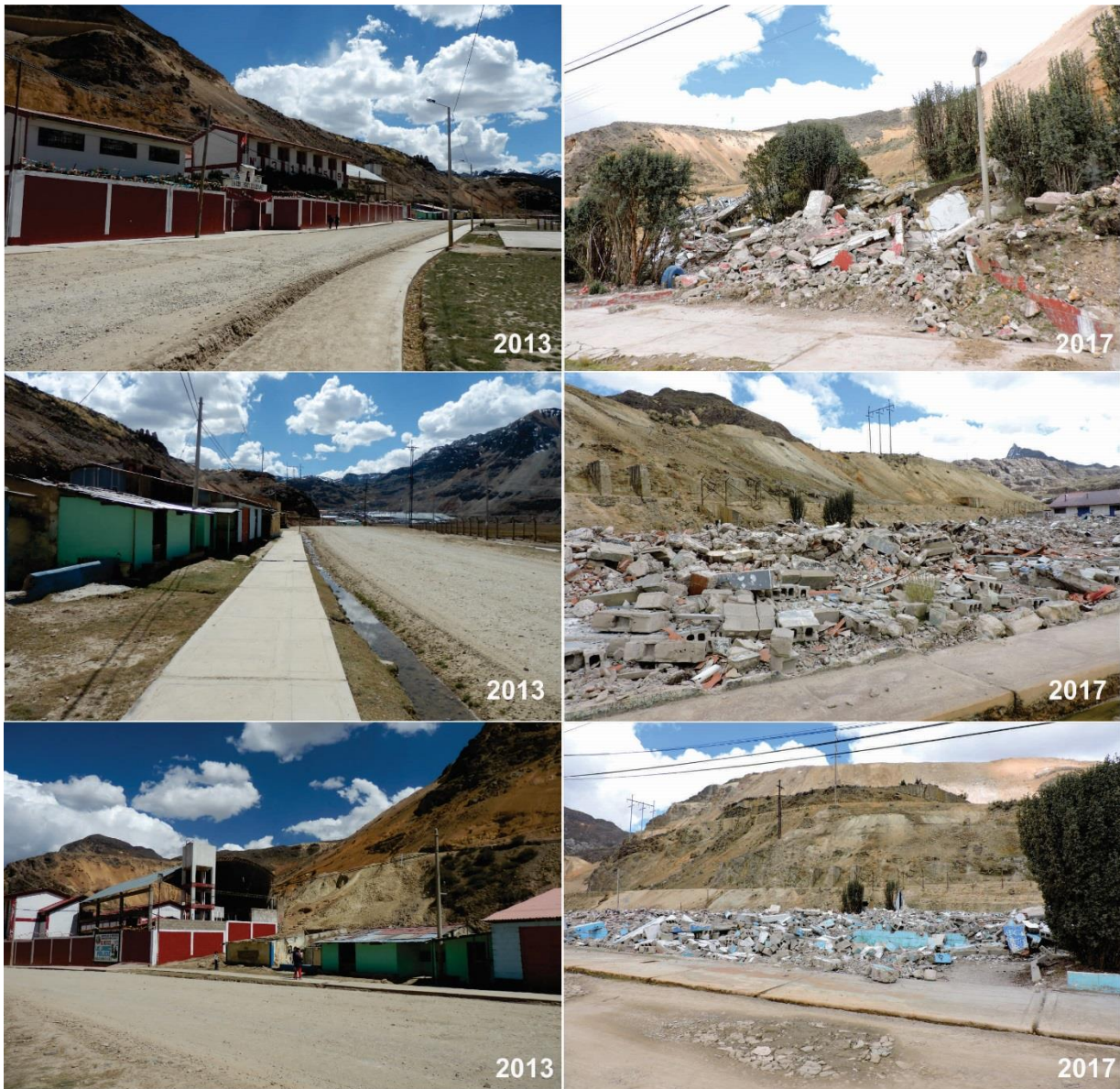
Foto 9. Viviendas e infraestructuras demolidas en Morocha antigua; actualmente la ciudad carece de establecimientos de salud y educación.
