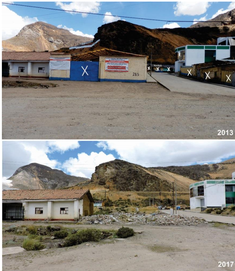
Foto 2. Viviendas demolidas marcadas con una “x”, en el sector Morococha Nueva, en la ex Carretera Central.
