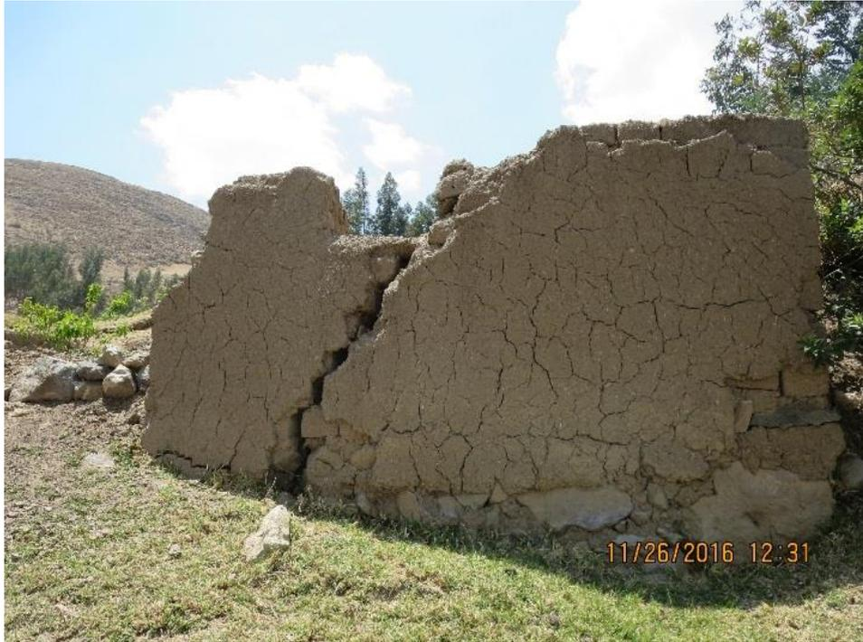
Foto 8. Vista de vivienda afectada por el movimiento, dejando paredes agrietadas.
