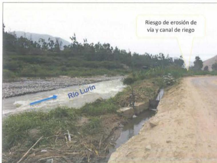
Figura 11. Riesgo de erosión de vía afirmada y canales de riego
