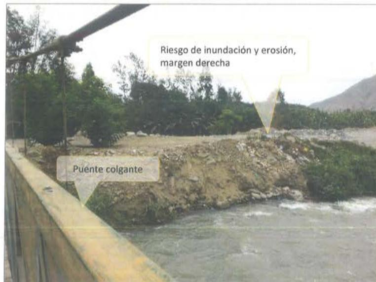
Figura 10. Inundación y erosión del puente colgante, y PTAR Cieneguilla
