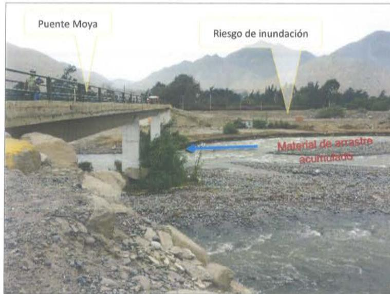
Figura 8. Riesgo de inundación de viviendas y puente vehicular puente Moya
