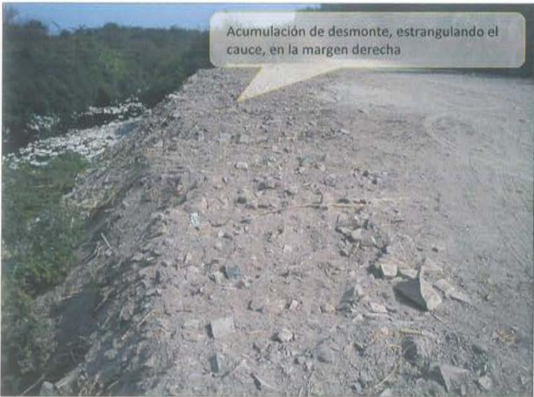
Figura 23. Estrangulamiento del cauce con desmonte
