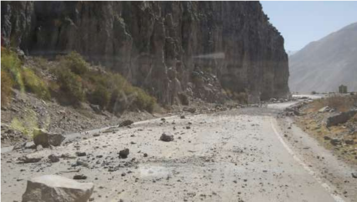
MM23: Caída de rocas.
