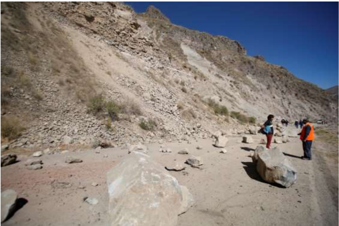
MM04: Caída de rocas.
