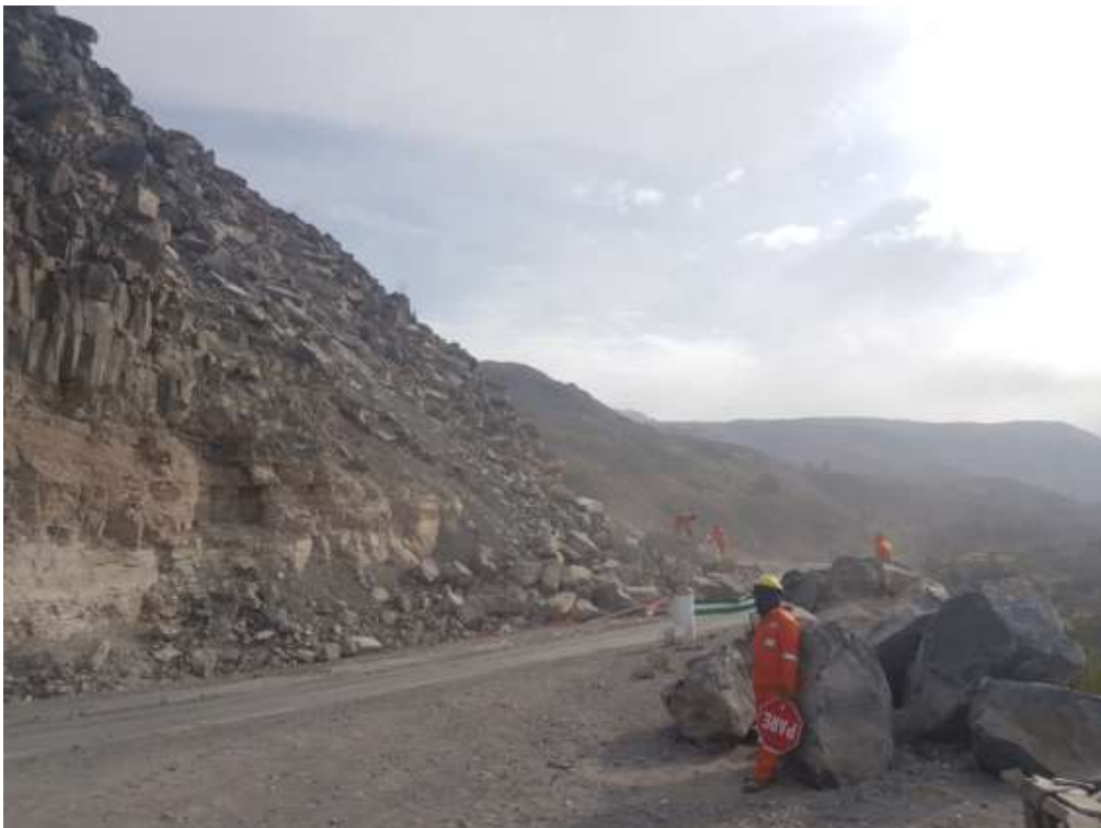
Foto 4: Caída de rocas (Derrumbe) en el tramo de la carretera Achoma-Maca. Margen izquierda del río Colca.
