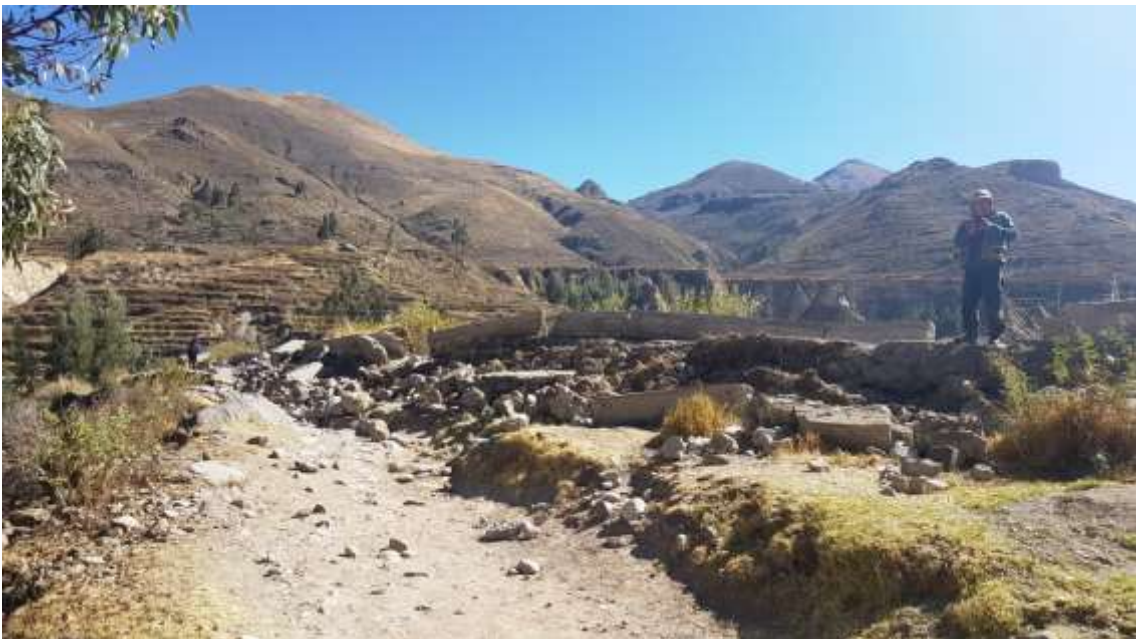
Foto 12: Canal destruido por efecto de la amplificación de ondas sísmicas, el suelo y el tipo de construcción.
