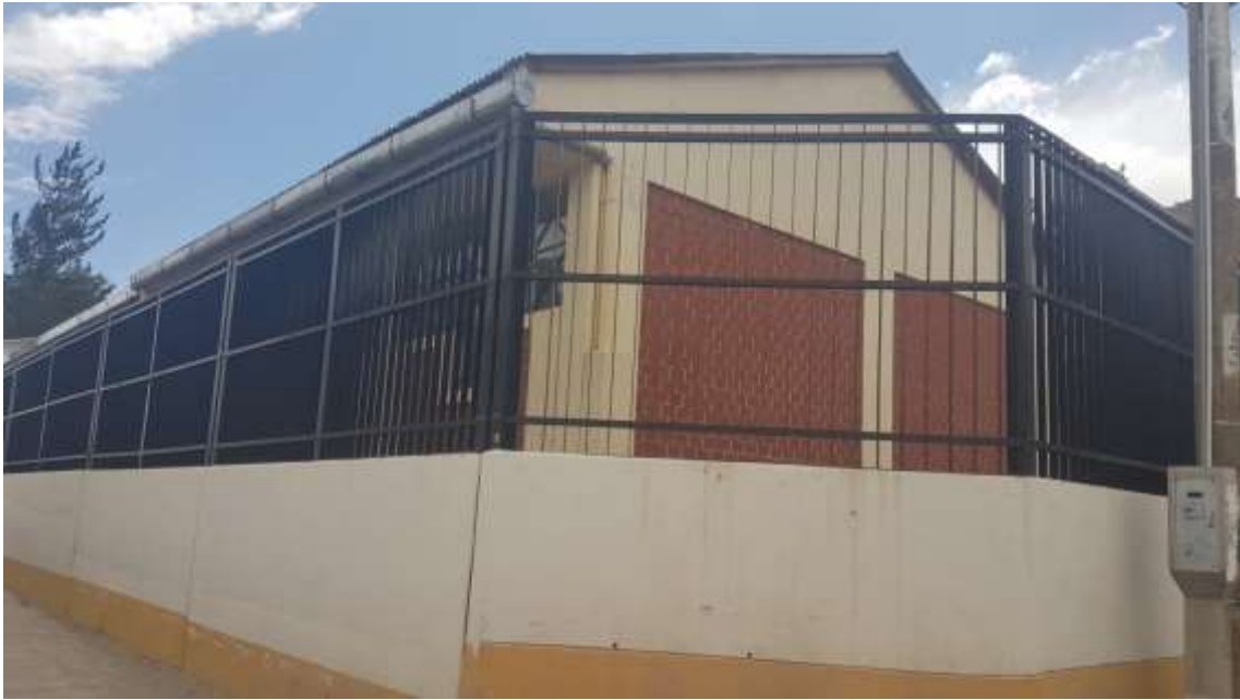
Foto 09: Construcción de un piso de material noble que no sufrió daños por efecto del sismo.
