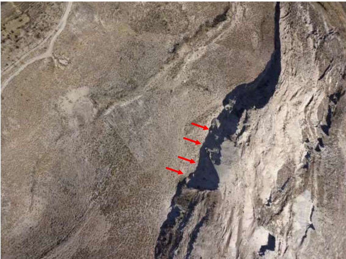
MM18: Deslizamiento. (Fotografía aérea - Drone)
