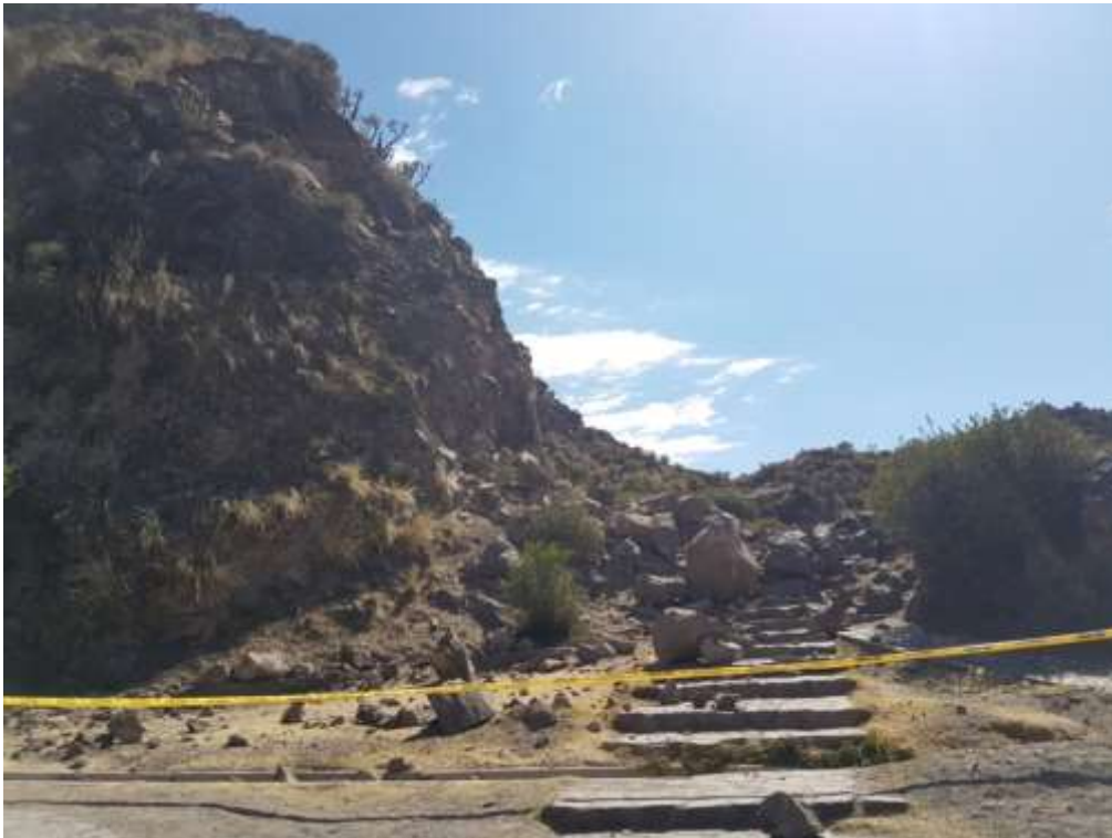
Foto 3: Caída de rocas en Chivay, margen izquierda del río Colca.
