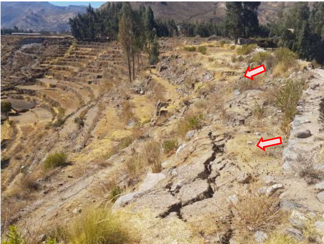
MM10: Deslizamiento afectando la andenería.
