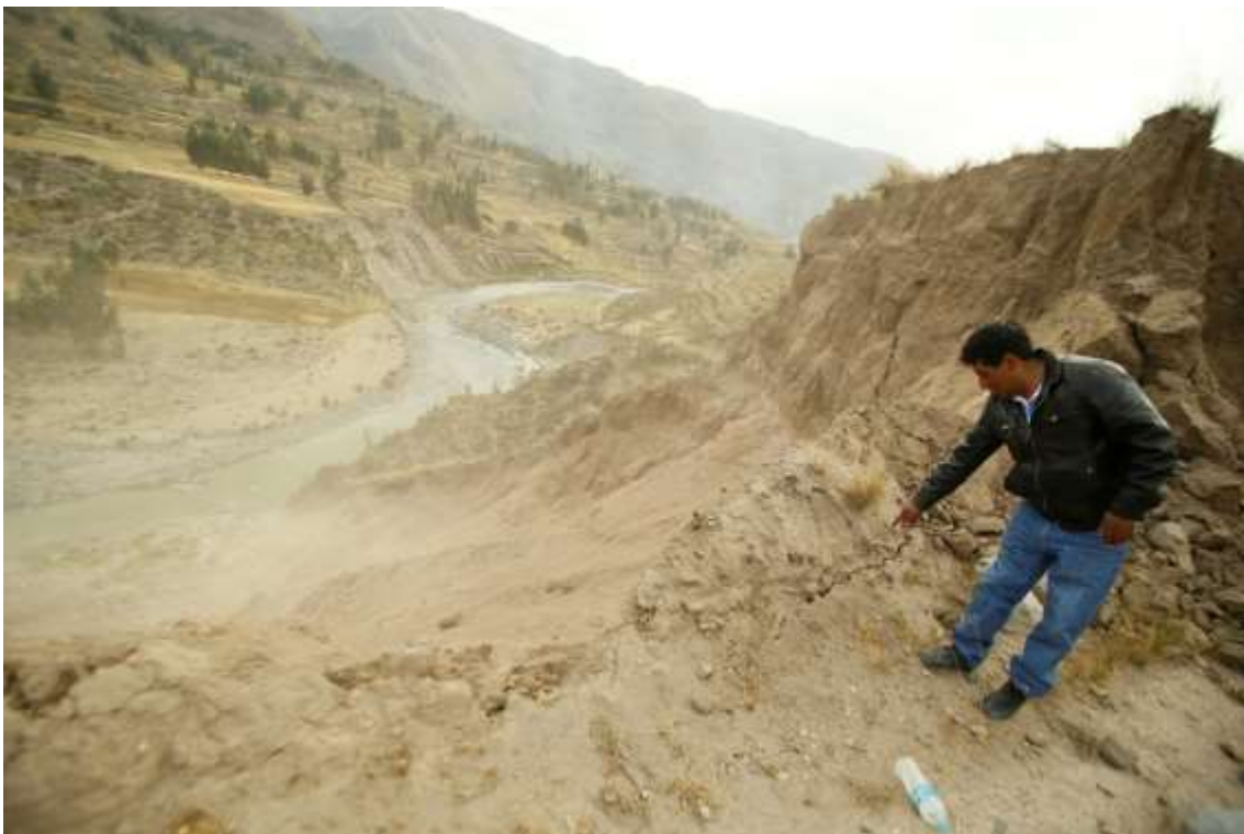
Foto 2: Deslizamiento en la carretera Ichupampa – Lari, margen derecha del río Colca.
