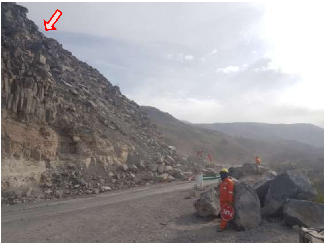
MM24: Caída de rocas - Derrumbe.
