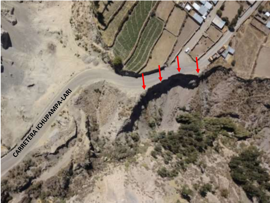
MM21: Deslizamiento. (Fotografía aérea - Drone)
