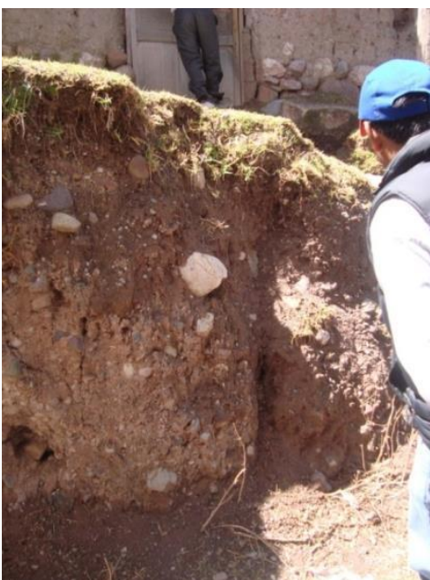
Foto 3. Zona urbana de Chincho, en un corte de talud, se muestra la heterogeneidad del suelo.
