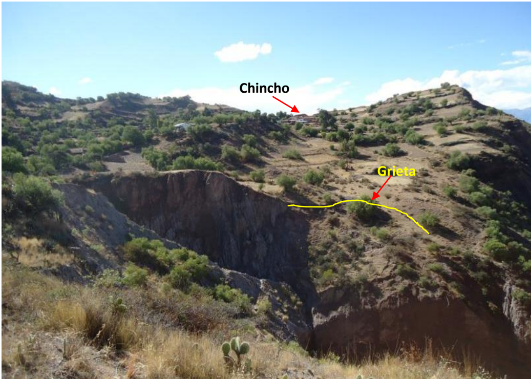
Foto 12. Vista de la quebrada Pachayarcu mostrando grietas en la cabecera del talud lo que representaría la inestabilidad de estas laderas.
