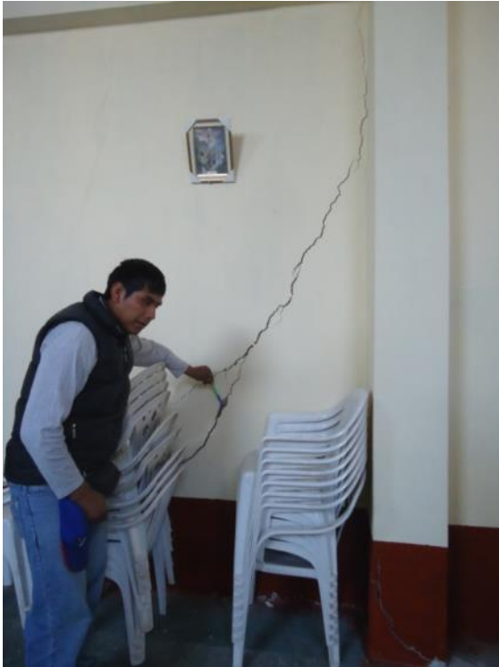
Foto 5. Grietas en las paredes y piso al interior de la iglesia producto de los asentamientos diferenciales ocurridos.
