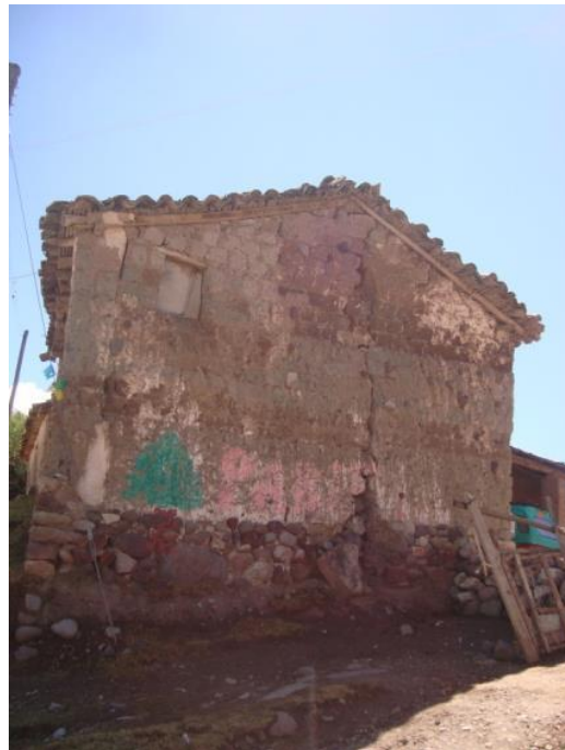
Foto 6. Vista de vivienda mostrando los efectos de los asentamientos diferenciales.
