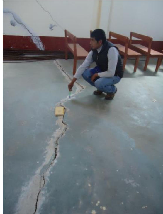
Foto 5. Grietas en las paredes y piso al interior de la iglesia producto de los asentamientos diferenciales ocurridos.
