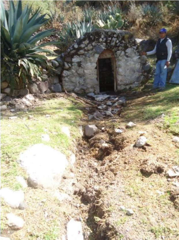
Foto 8. Fuente de agua no recubierta ni canalizada adecuadamente presentando con flujo constante durante todo el año pero no es usada para el consumo humano agropecuario.
