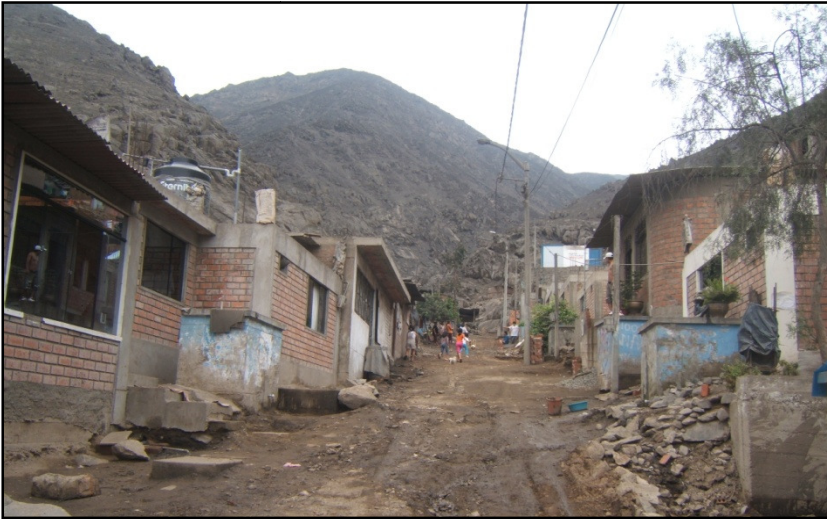
Foto N° 10.- Viviendas del AA.HH. Nuevo Amanecer asentadas en pleno cauce de la quebrada.
