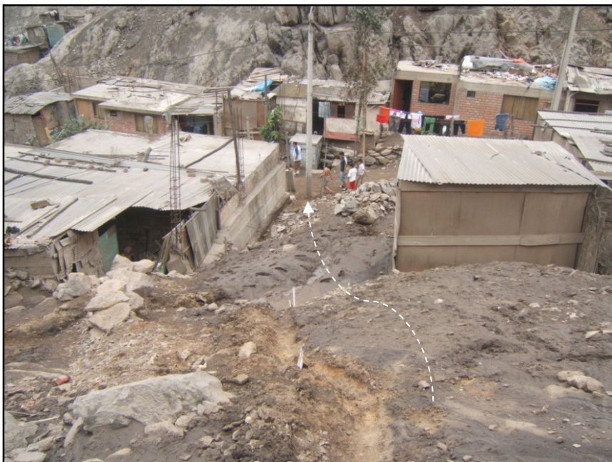
Foto N° 12.- Otra vista del material no canalizado, que afectó viviendas ubicada en la ladera.
