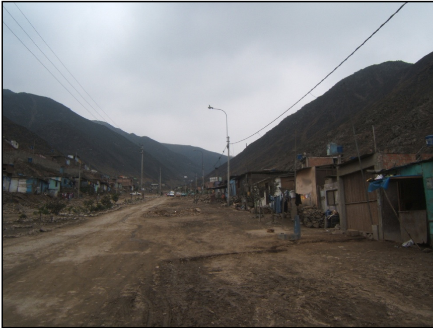
Foto N° 6.- Sector por donde se canalizó el flujo de lodo.
