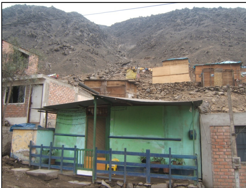
Foto N° 16.- Acumulación de bloques sueltos (canchales), producto de antiguas caídas de rocas.
