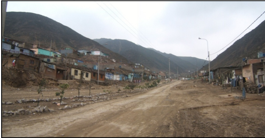
Foto N° 3.- Quebrada Collique, vista aguas arriba, se observa las laderas de los cerros con fuerte pendiente.
