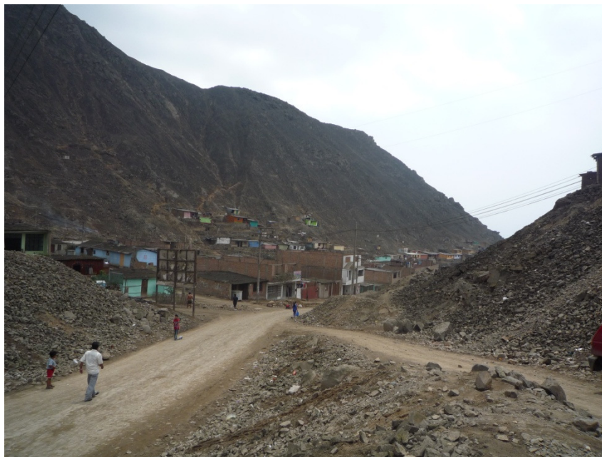
Foto N° 5.- Laderas de la quebrada con ausencia de vegetación
