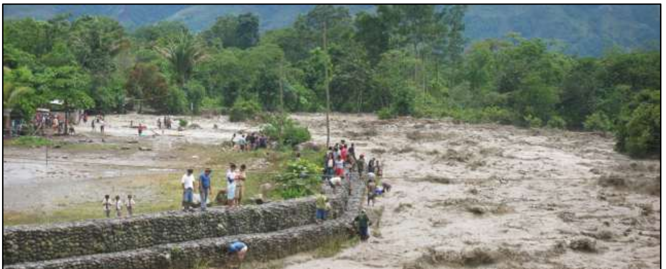
Foto 7.- Se muestra las áreas inundadas por la margen izquierda del río Santa Rosa (Foto cortesía de la Municipalidad de Santa Rosa).
