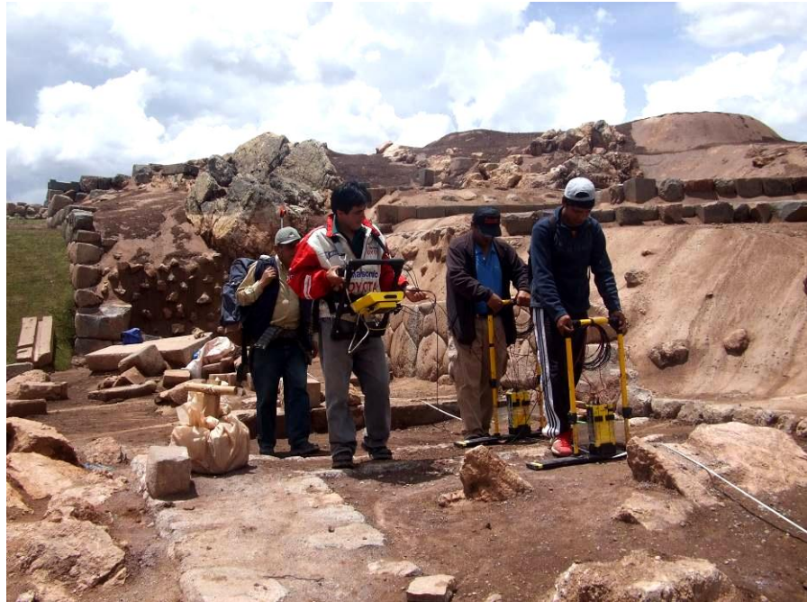
Foto N° 11: Vista de la ubicación de la línea de Georadar LR-23 a lo largo del canal o Dren propuesto.
