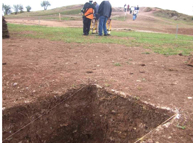
Foto N° 2: Ubicación de la línea de georadar L-9 en la zona crítica 3 – parte superior de los Baluartes - Saqsaywaman..
