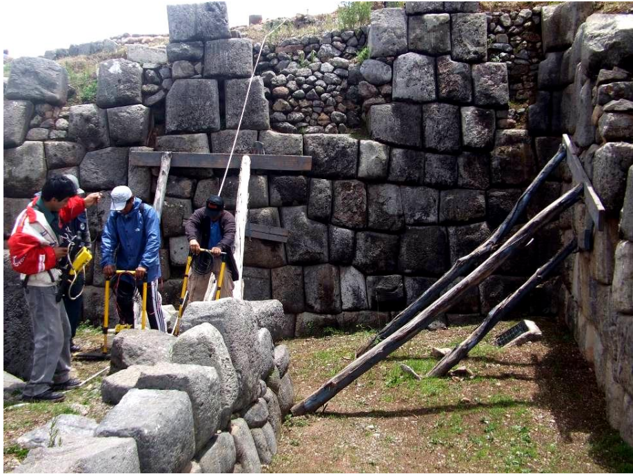
Foto Nº 13: Vista de la ubicación de la línea de Georadar LR-12 en la zona crítica de pandeamientos-Zona 1..
