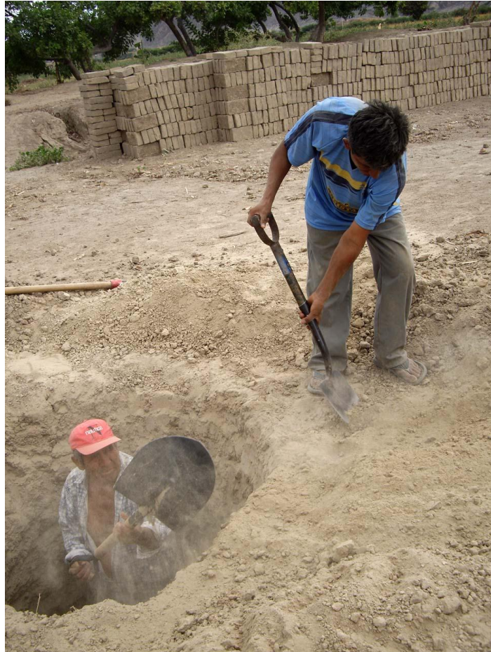
Foto N° 3 – Ejecución de la excavación de una de las calicatas en el área de Sacta, donde se observa el material con granulometría fina limo arcillosa.
