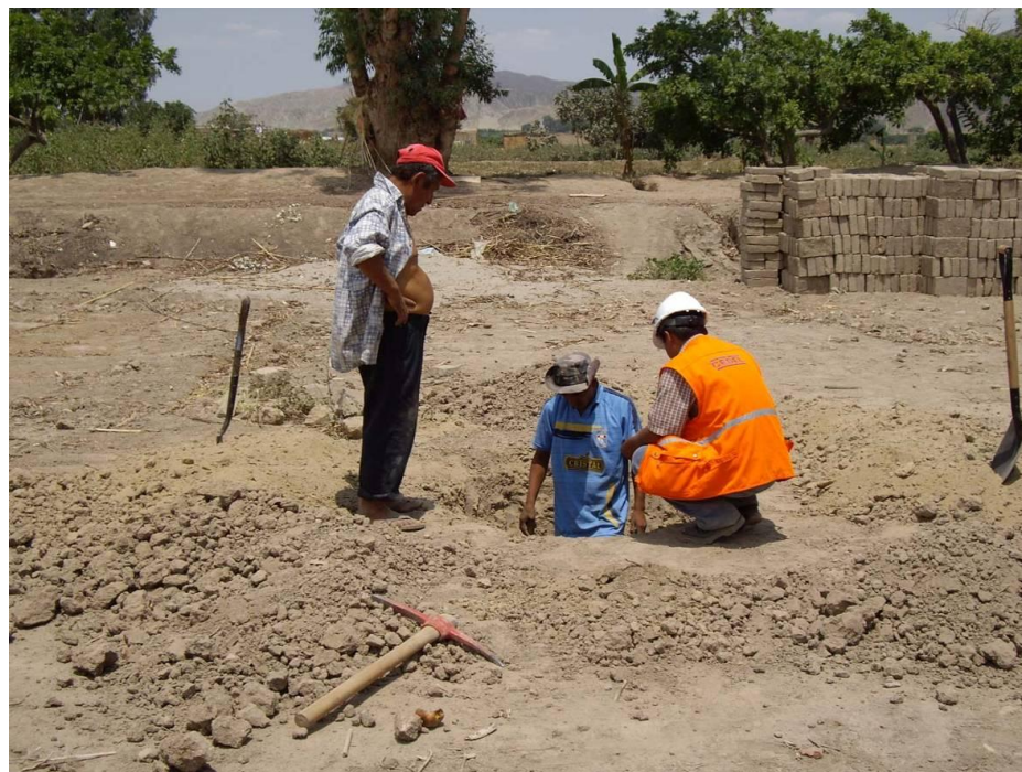
Foto N° 5 – Personal de CESEL supervisando una calicata donde también se observa el material fino limo arcilloso hasta una profundidad de 3 m.
