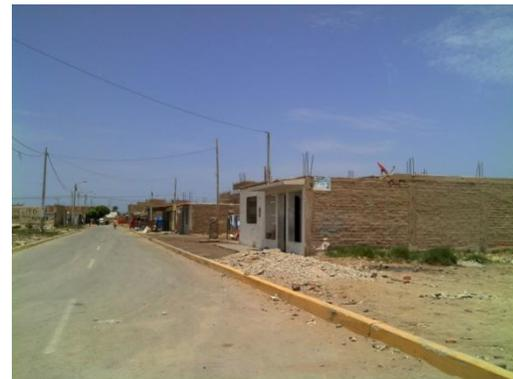
Figura 15. Viviendas de un piso de albañilería confinada.
