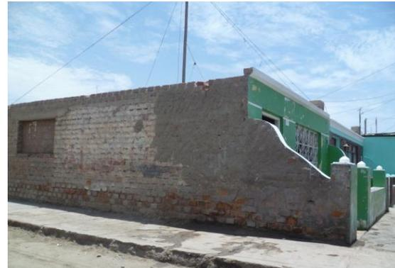
Figura 20. Vivienda informal de un piso con presencia de humedad en la base.
