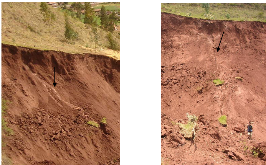
Foto 12. Aguas procedentes del manante de la parte superior. a) foto tomada el 30-11-07 donde se aprecia mayor cantidad de agua. b) foto tomada el 26-12-07 donde casi ha desaparecido el flujo de agua.
