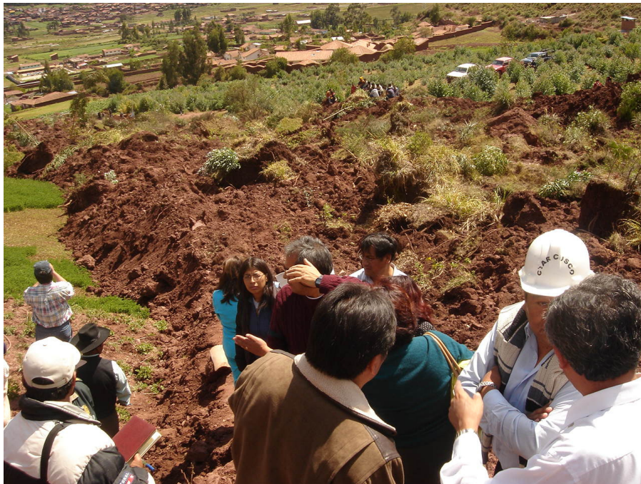
Foto 31. Borde del flujo F-2 cuyo material casi seco se ha desparramado sobre el borde de la quebrada
