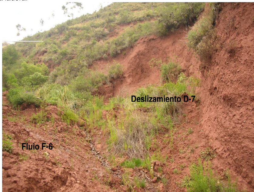
Foto 48. Deslizamiento D-7 y parte del flujo F-6
