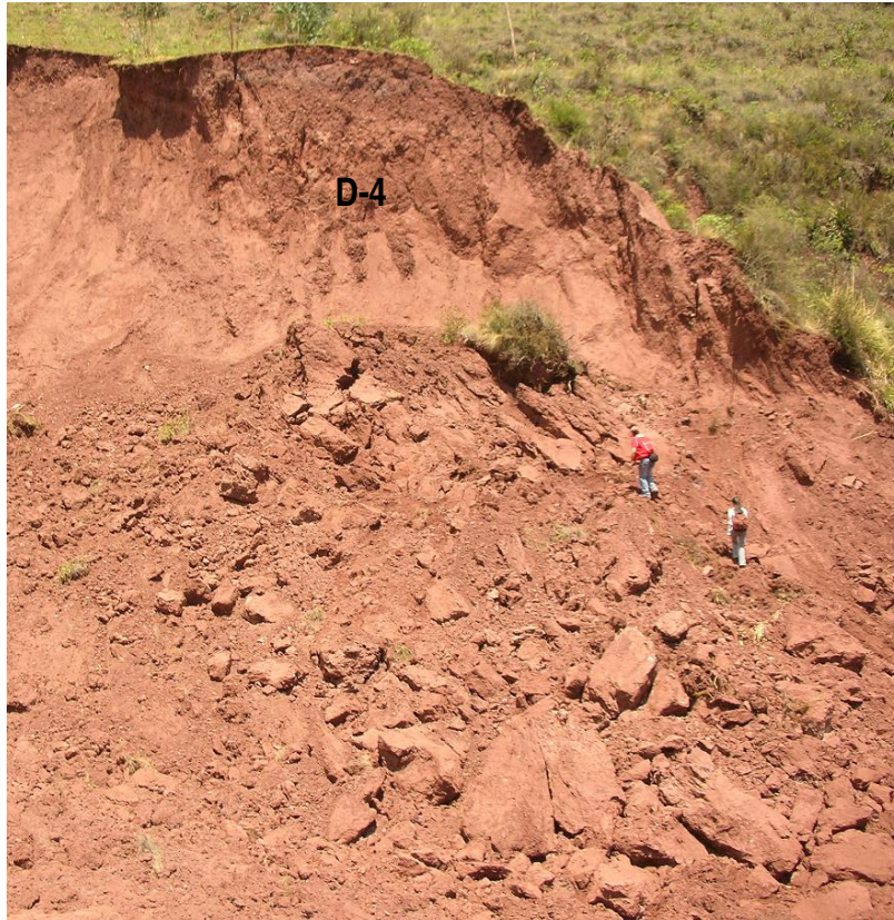
Foto 16. Escarpa D-4 con el material deslizado y bloques de depósitos aluviales
