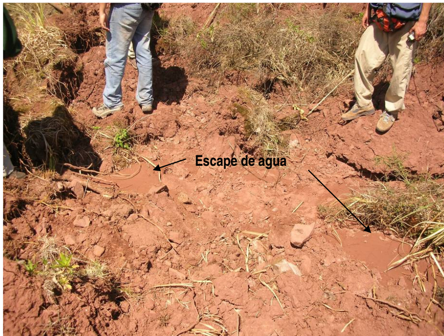
Foto 36. Escape de agua entre los flujos F-3 y F-2
