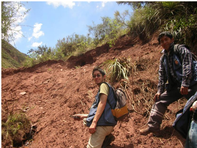
Foto 47. Escarpa de deslizamiento D-5
