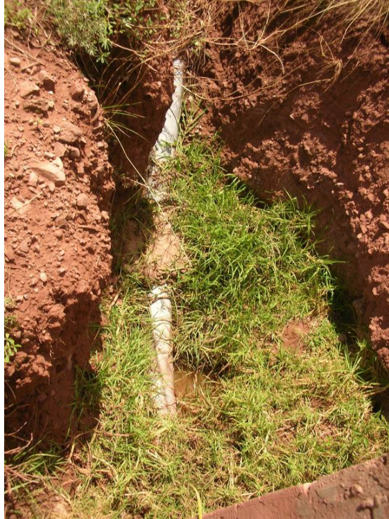
Foto 62. Estribo E-1 del acueducto T-1 y entrada del agua
