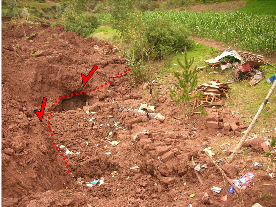
Foto 25. Casa destruida por el Flujo F-1. Nótese que parte del flujo paso por encima de la vivienda, tal vez aprovechando un desnivel existente
