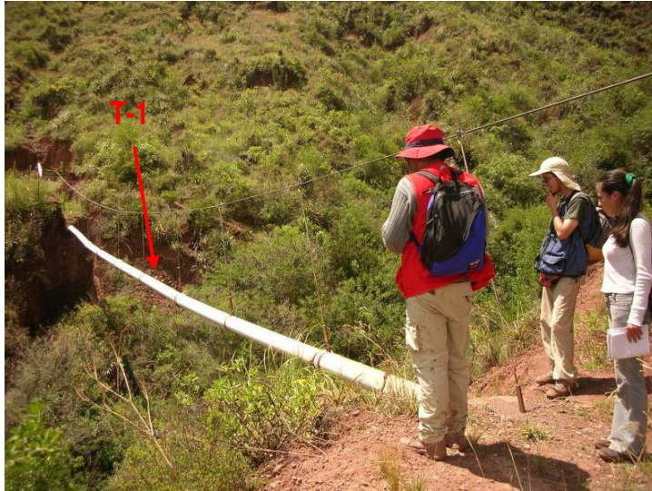
Foto 60. Acueducto T-1 que cruza la quebrada Chingo Grande
