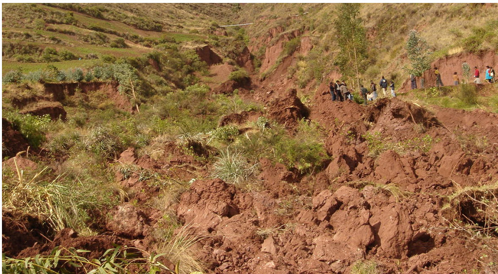
Foto 29. Grandes bloques de suelos aluviales del frente del flujo F-2, cuyo espesor de flujo es de 3 m
