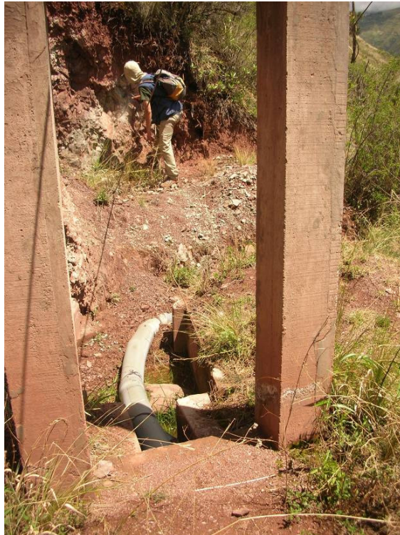
Foto 61. Estribo E-2 y salida del acueducto T-1 con tubos PVC
