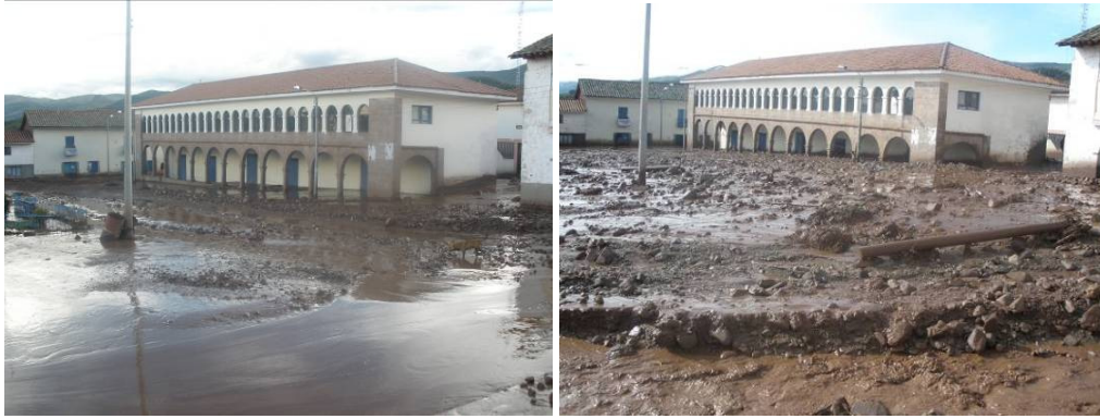
Fotos 13 y 14: Plaza de Armas de Zurite afectada por el aluvión del 28 de enero (izquierda) y el aluvión del 06 de febrero (derecha).
