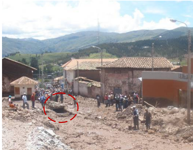
Foto 21: Canalización cubierta en la calle Kennedy.
