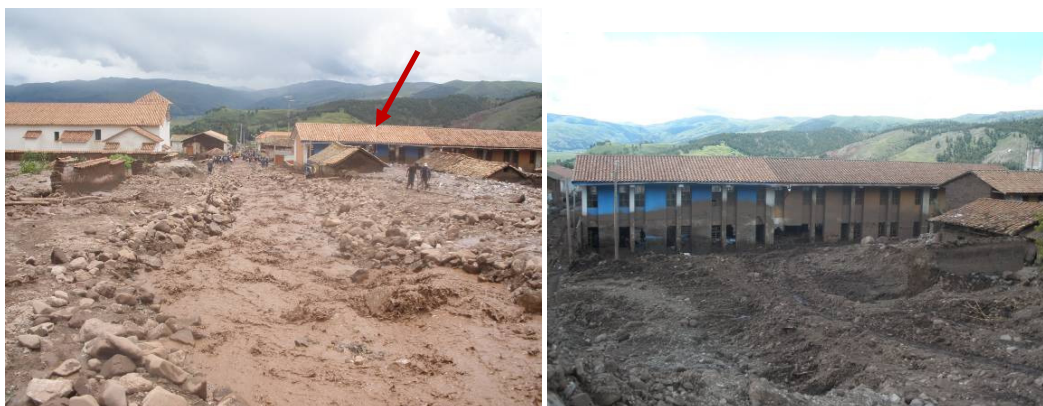
Fotos 25 y 26: Unidad Escolar Mixta Nro 118-Zurite y viviendas situadas al norte, afectada el aluvión del 6 de febrero del 2010.
