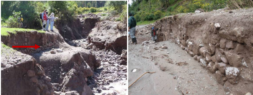
Fotos 15 y 16: Muros incas parcialmente destruidos a la margen derecha de la quebrada.
