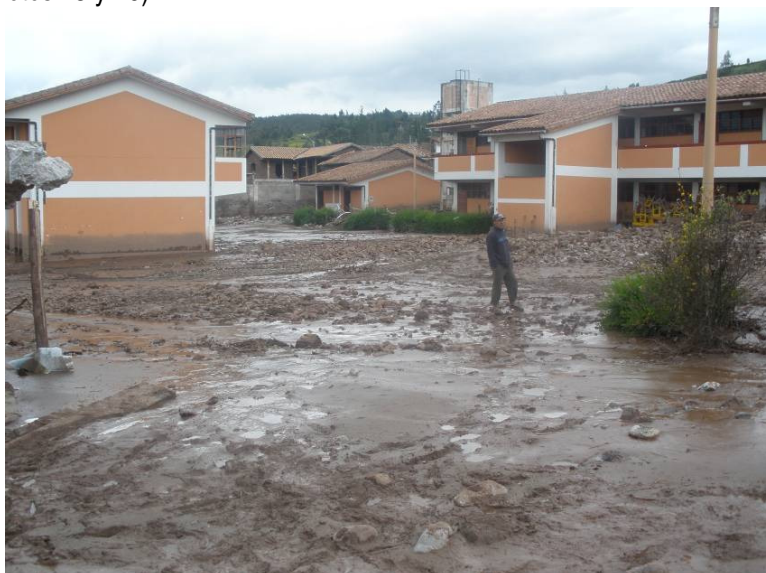
Foto 24: Colegio afectado por el aluvión del 6 de febrero, 2010.
