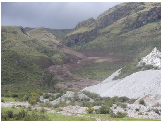
Foto 8: Desbordes y rebalses a la margen izquierda de la quebrada, en el tramo 1.
