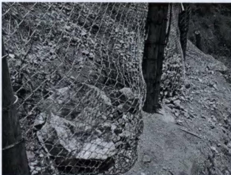
Foto 03: Rocas y detritos caídos durante el sismo del 15/08/07 que demostraron la efectividad de las barreras dinámicas colocadas en el área adyacente de peligrosidad por caída de rocas.
