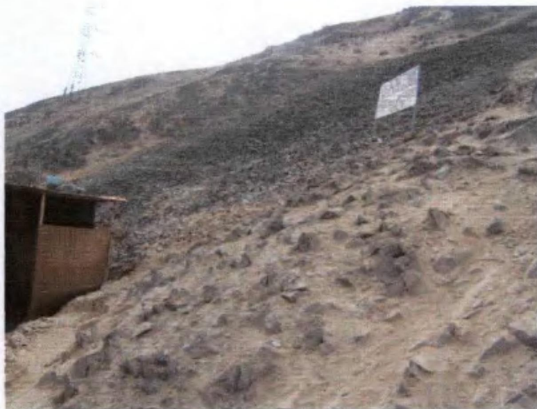
Foto N° 5. Obsérvese los fragmentos de rocas acumuladas en la manzana "A", producto de la caída de rocas.
