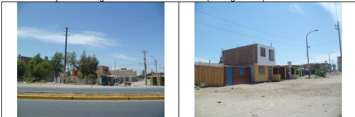
Figura 142. Vista de las viviendas del sector 19 de Pisco.
