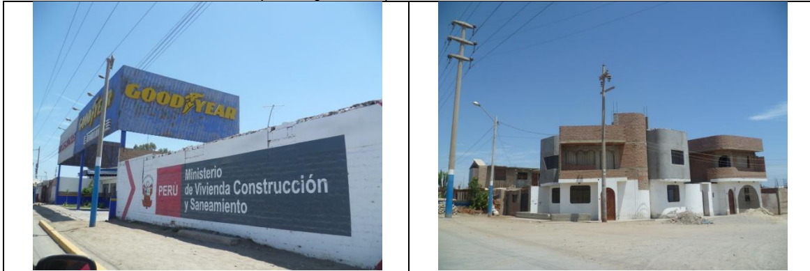
Figura 130. Vista de las viviendas del sector 13 de Pisco.
