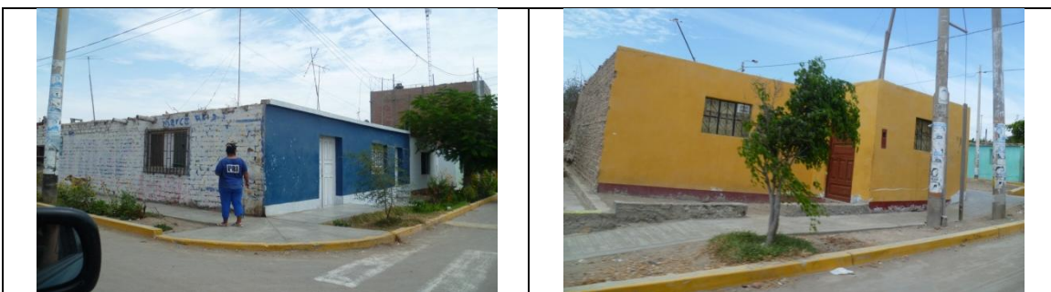
Figura 95. Viviendas de albañilería informal.
