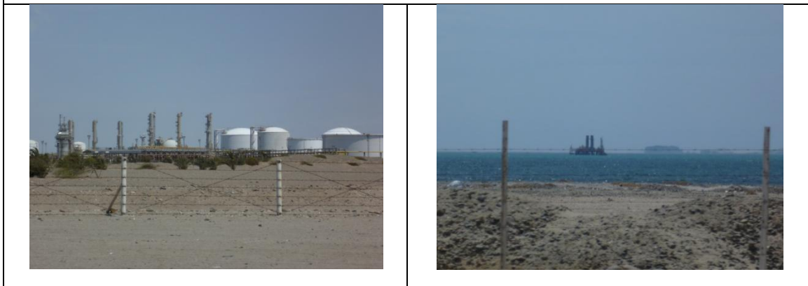
Figura 64. Refinería de Pluspetrol.
