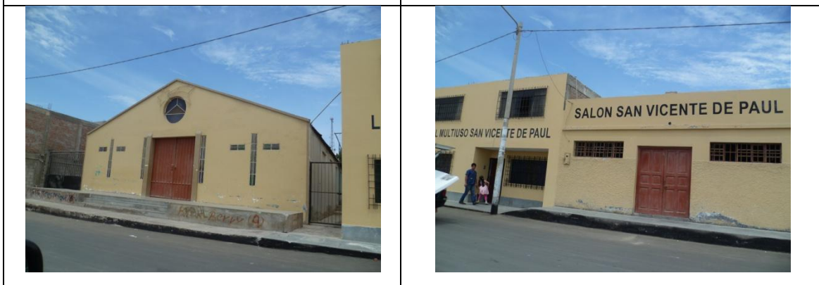
Figura 92. Iglesia, local multiuso y salón San Vicente de Paul.
