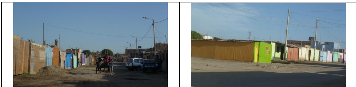
Figura 115. Vistas de viviendas del Sector 05.
