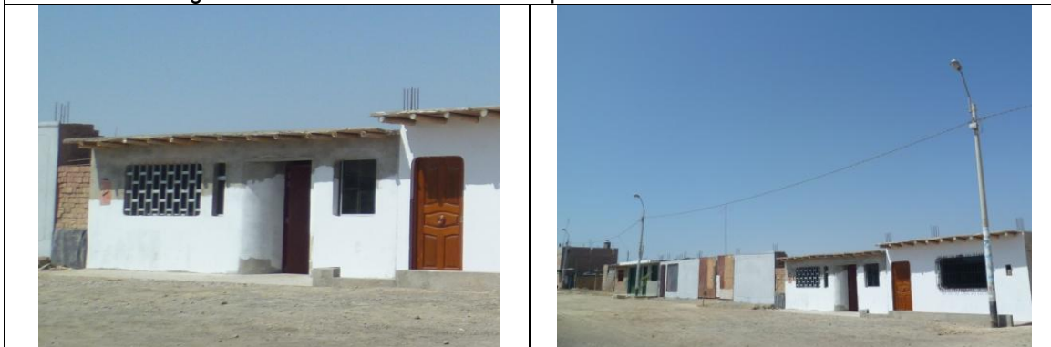
Figura 42. Vista de viviendas informales de un piso de albañilería en sector 02.
