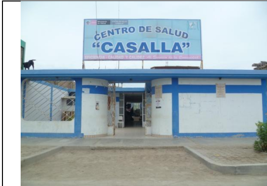
Figura 83. Centro de Salud Casalla.
