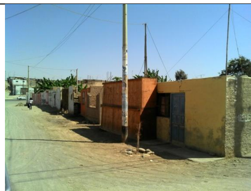
Figura 38. Vista de viviendas de un piso.
