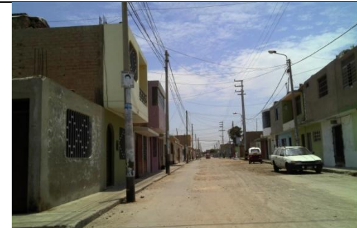
Figura 8. Vista de viviendas de un piso y 2 pisos albañilería confinada.
