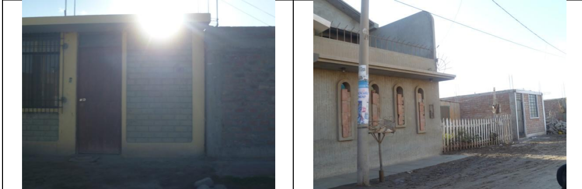
Figura 113. Viviendas de albañilería confinada del Sector 04.
