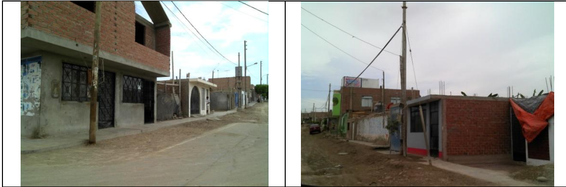
Figura 81. Viviendas típicas del Sector 01.
