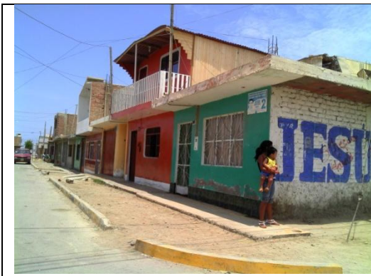
Figura 5. Vista de viviendas de un piso y 2 pisos.
