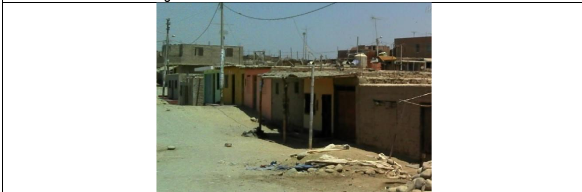
Figura 56. Vistas de las viviendas de adobe y quincha con regular estado de conservación.
