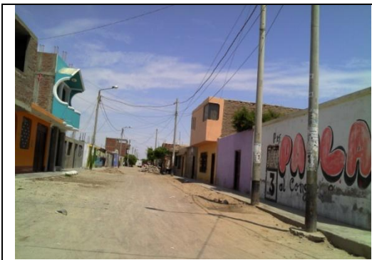
Figura 18. Vista de viviendas de uno y dos pisos albañilería confinada.
