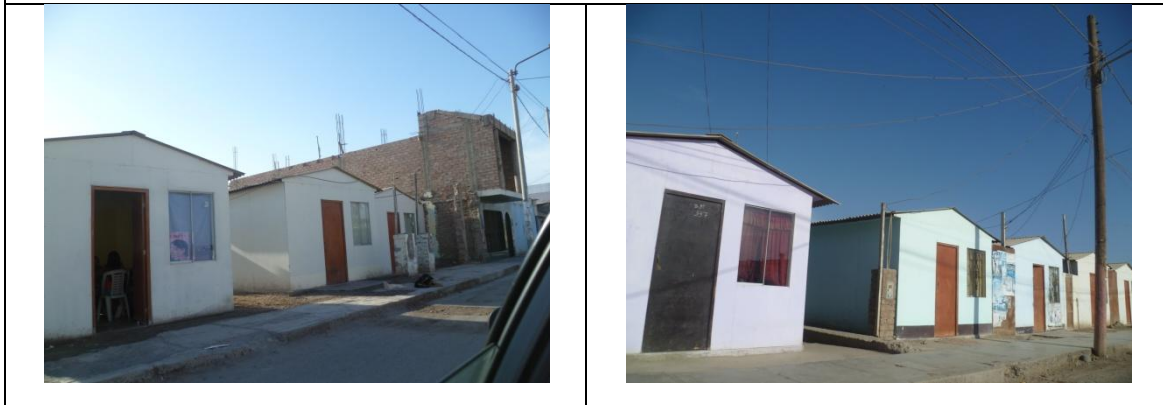
Figura 121. Vistas de las viviendas de drywall del sector 10.
