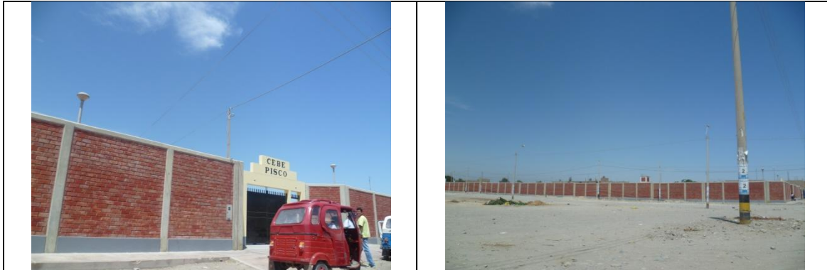
Figura 141. Vista de Centro Educativo C.E. "Pisco"- sector 18 de Pisco.
