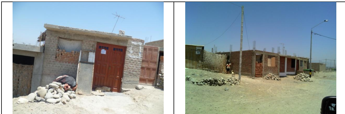
Figura 44. Vista de viviendas de albañilería del Sector 04.
