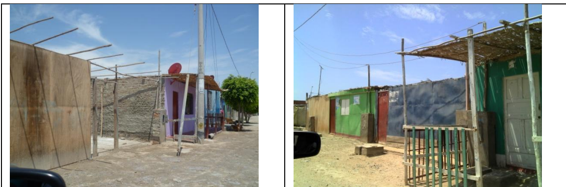
Figura 24. Vista de viviendas informal de un piso del sector 05.
