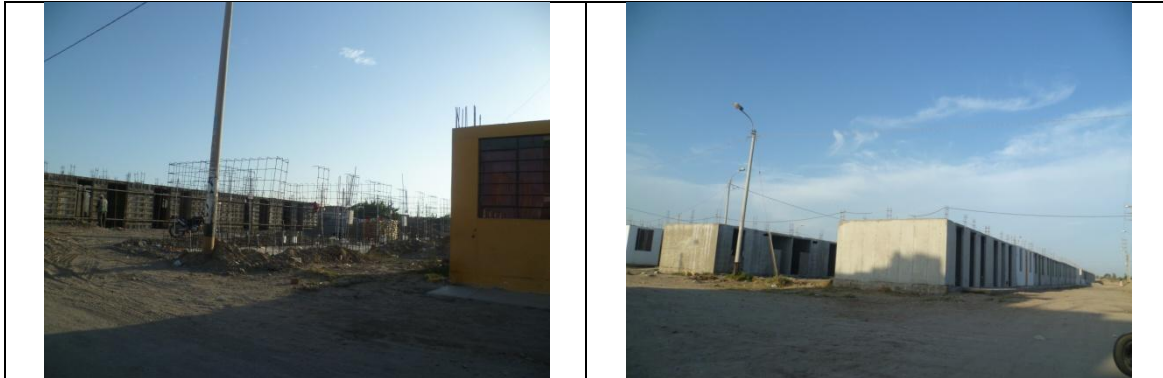
Figura 118. Vistas de las viviendas con muros de ductilidad limitada.
