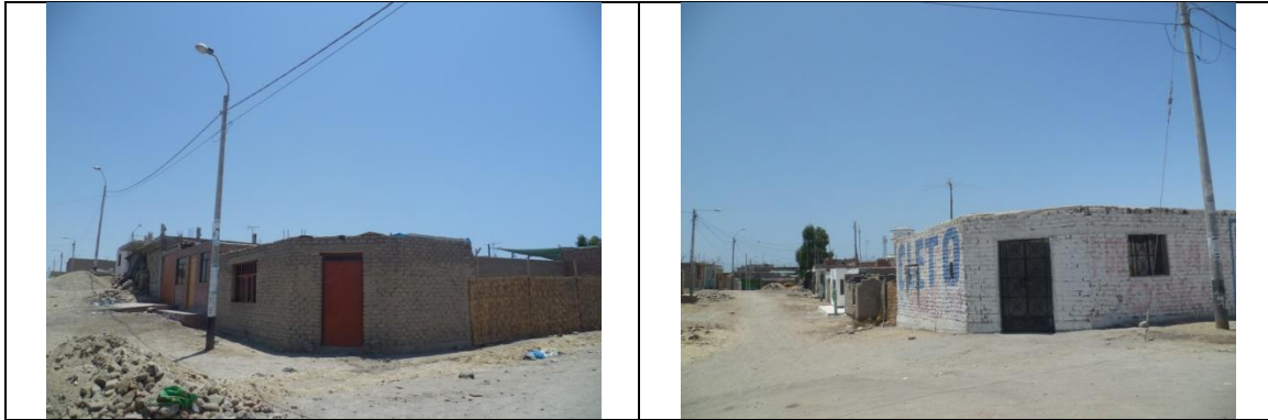
Figura 46. Vistas de viviendas de adobe del Sector 04.
