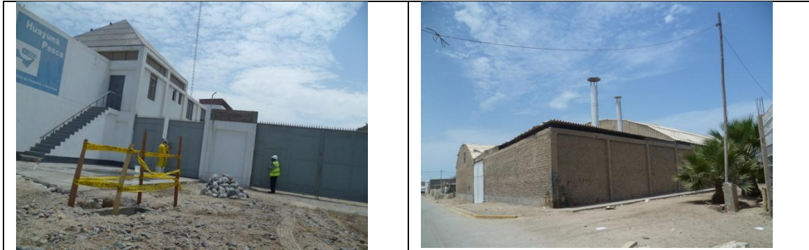
Figura 7. Vista de edificaciones industriales.
