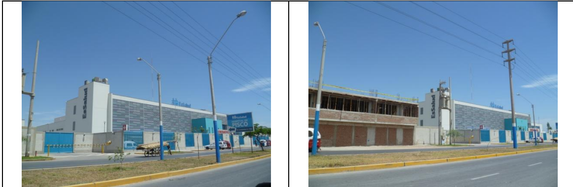
Figura 143. Vista del Hospital de ESSALUD en sector 19 de Pisco.
