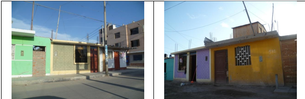
Figura 114. Viviendas de albañilería confinada Sector 05.
