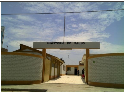
Figura 12. Vista de Centro de salud - Sector 03.
