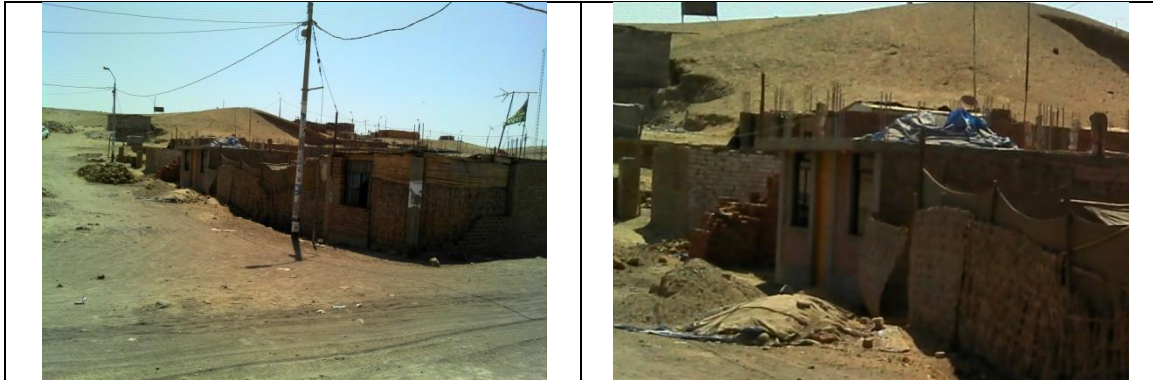
Figura 41. Vista de viviendas de un piso de albañilería en sector 02.
