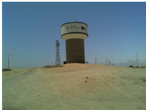
Figura 47. Reservorio de Agua del Sector 04.
