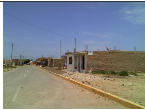
Figura 6. Viviendas de un piso de albañilería confinada.
