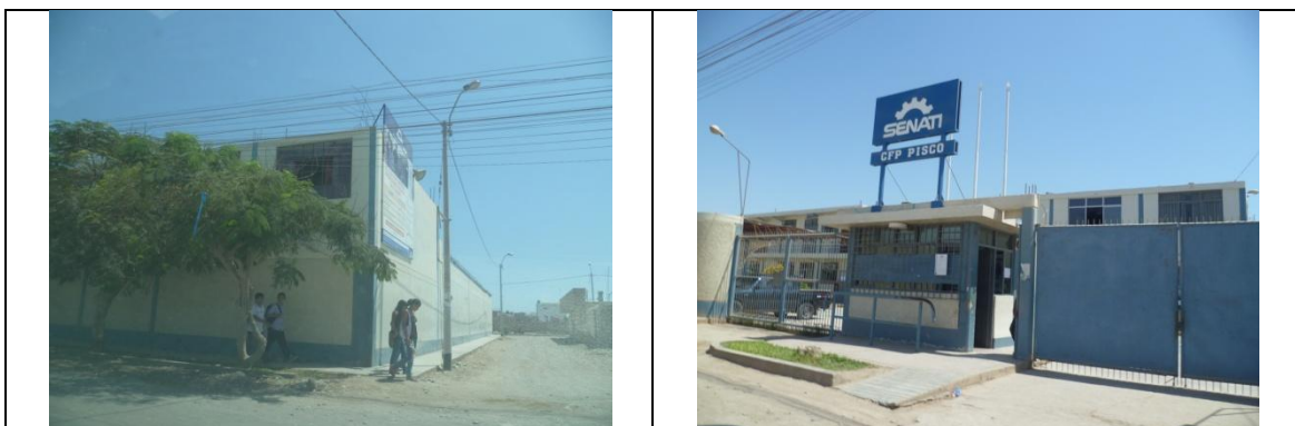
Figura 138. Vista del SENATI del sector 17 de Pisco.
