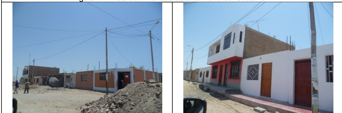
Figura 45. Viviendas de albañilería del Sector 04.
