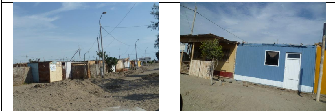
Figura 67. Viviendas de madera.
