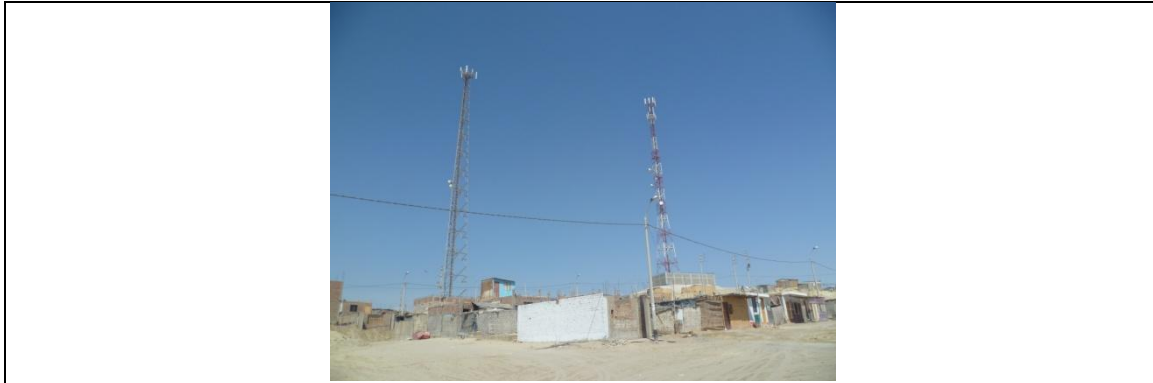
Figura 103. Torres metálicas para antenas de comunicación.
