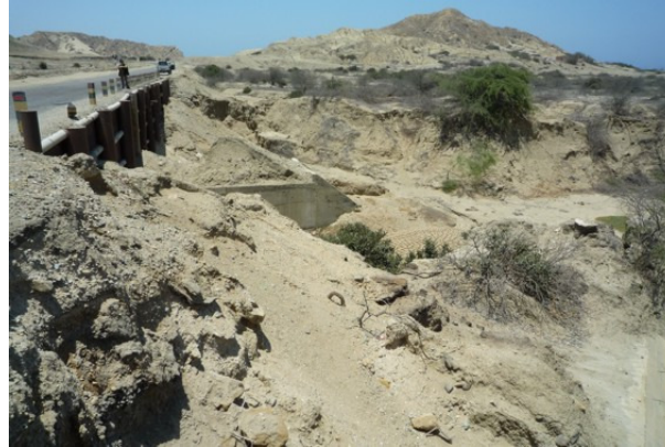
Carretera Talara-Negritos, cortada en varios sectores por torrenteras que se activan excepcionalmente.
