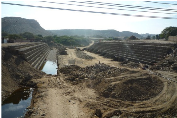
Vista de la Quebrada encauzada con gaviones ubicada al norte de Talara, torrenteras por donde discurren flujo de lodo excepcionalmente. En el acantilado se presentan caída de rocas.
