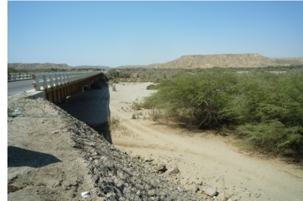
Carretera Panamericana Norte, entre las quebradas Pariñas y Honda. Tramo cortado de la carretera se ha variado el Trazo. Gaviones colocados en estribo de puente Quebrada Seca.
