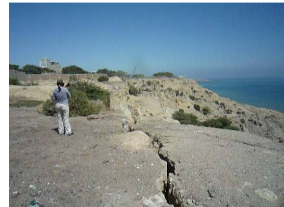
Acantilados de Paita afectados por deslizamientos rotacionales activos, los cuales comprometen la seguridad física de la infraestructura ubicada detrás de la corona de los deslizamientos.
