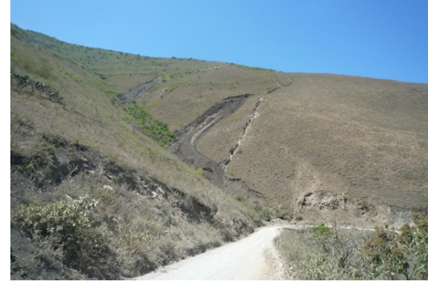
Tramos de la carretera de acceso ha Ayabaca, afectados por deslizamientos, erosión de laderas y flujos de detritos.
