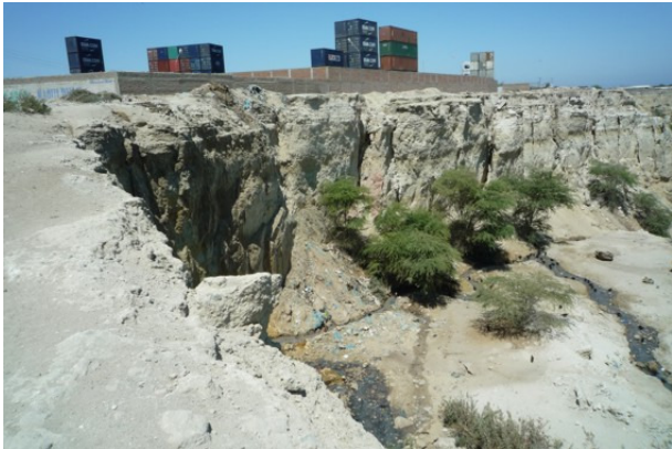
Acantilados de Paita afectados por deslizamientos rotacionales activos, los cuales comprometen la seguridad física de la infraestructura ubicada detrás de la corona de los deslizamientos.
