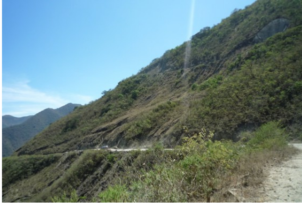
Tramos de la carretera de acceso ha Ayabaca, afectados por deslizamientos, erosión de laderas y flujos de detritos.
