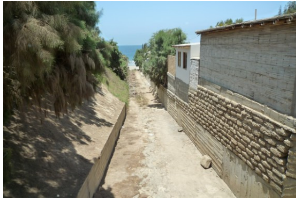
Torrenteras encauzadas en la ruta Las Pocitas-Vichayito, en Mancora.
