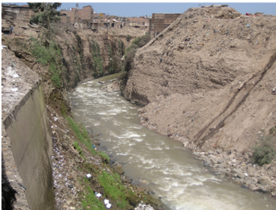
Foto: La forma encañonada del río Rímac, donde se puede observar, taludes de 15-18m de altura a la altura del Puente del Ejército
