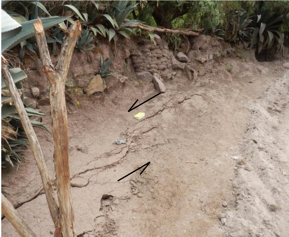
Foto 8: Grieta en el poblado de Misca, tiene una longitud de 15m con dirección preferente N110°, la abertura máxima es de 7 cm, se observa un tipo de movimiento sinistral.
