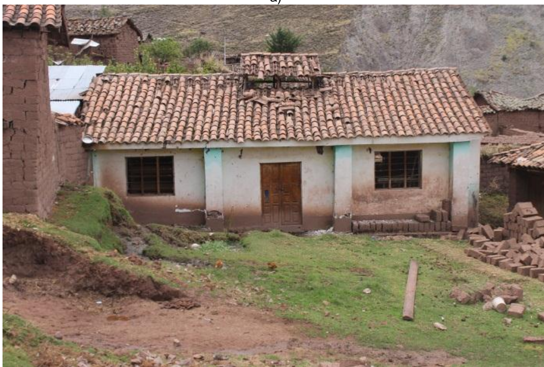
Foto 18: Viviendas de adobe en el poblado de Misca que no se destruyeron, sufrieron pocos daños fíjese los refuerzos y columnas.
