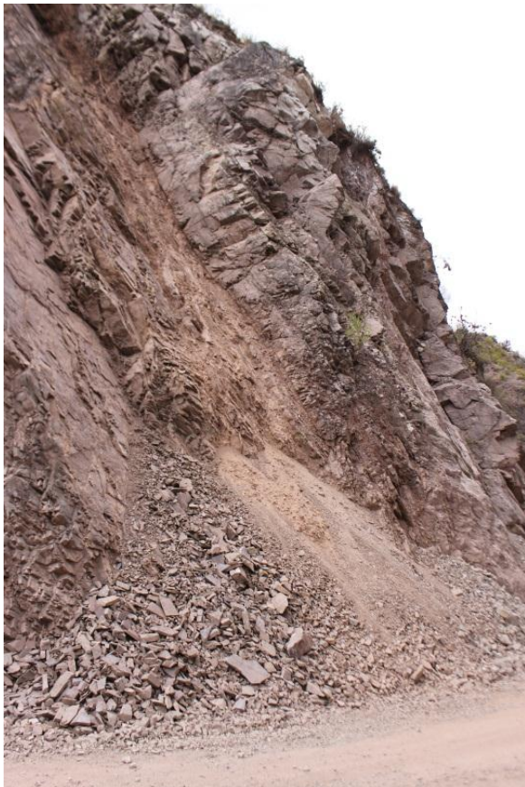
Foto 3: Deslizamientos traslacionales en areniscas. Tramo Misca – Cusibamba, margen izquierda del río Paruro.
