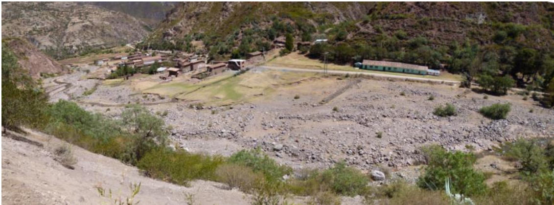
Foto 5: Valle del río Paruro y del poblado de Cusibamba bajo asentado en su margen izquierda cerca a la desembocadura en el río Apurímac, afectado por procesos de erosión fluvial y huaycos, se han colocado espigones con gaviones para evitar que el poblado se afectado.
