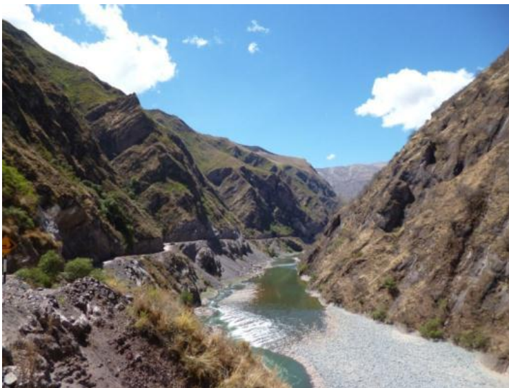
Foto 3: Carretera Cusibamba Bajo-Huaro Bamba trazado en la margen izquierda del valle del río Apurímac, en una ladera que supera los 40° de inclinación.
