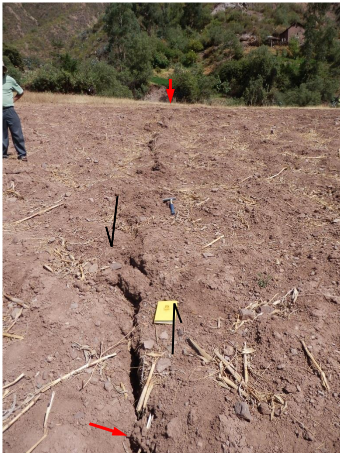
Foto 12: Grieta en el poblado Cusibamba Bajo, tiene una longitud de 100 m, su dirección es N126°, una abertura máxima de 20cm y una profundidad de 120cm. viene afectando terrenos de cultivo y la prolongación de esta grieta está alineada a las viviendas destruidas en esta localidad.
