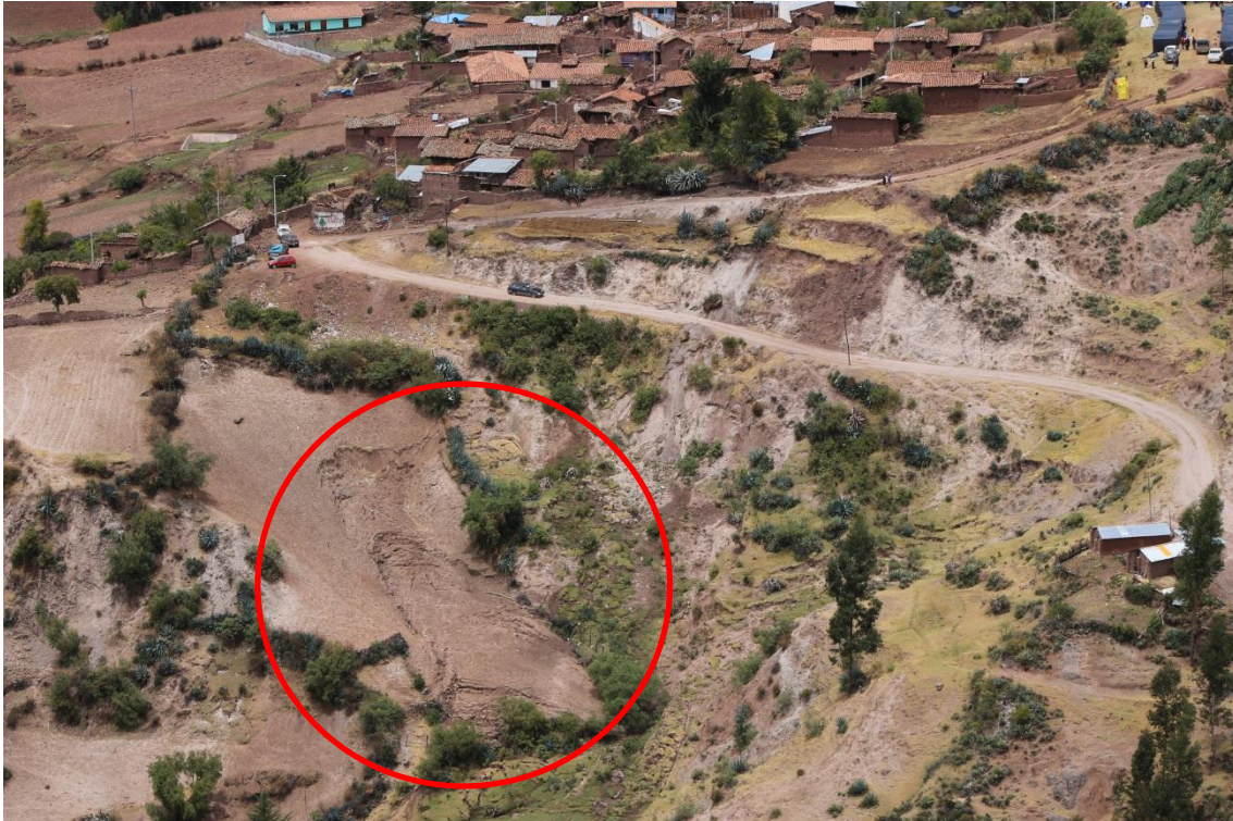
Foto 4: Cabecera del deslizamiento – flujo, se ubica a la entrada del poblado de Misca.
