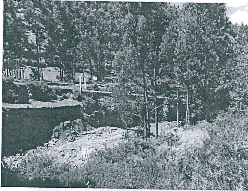
Fotografía 9. Infraestructuras afectada - Puente de peatonal acceso al puesto de salud.
