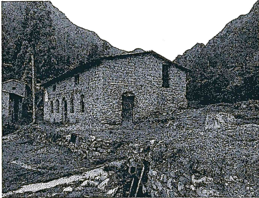
Fotografía 16. Infraestructuras afectada - Casa Comunal
