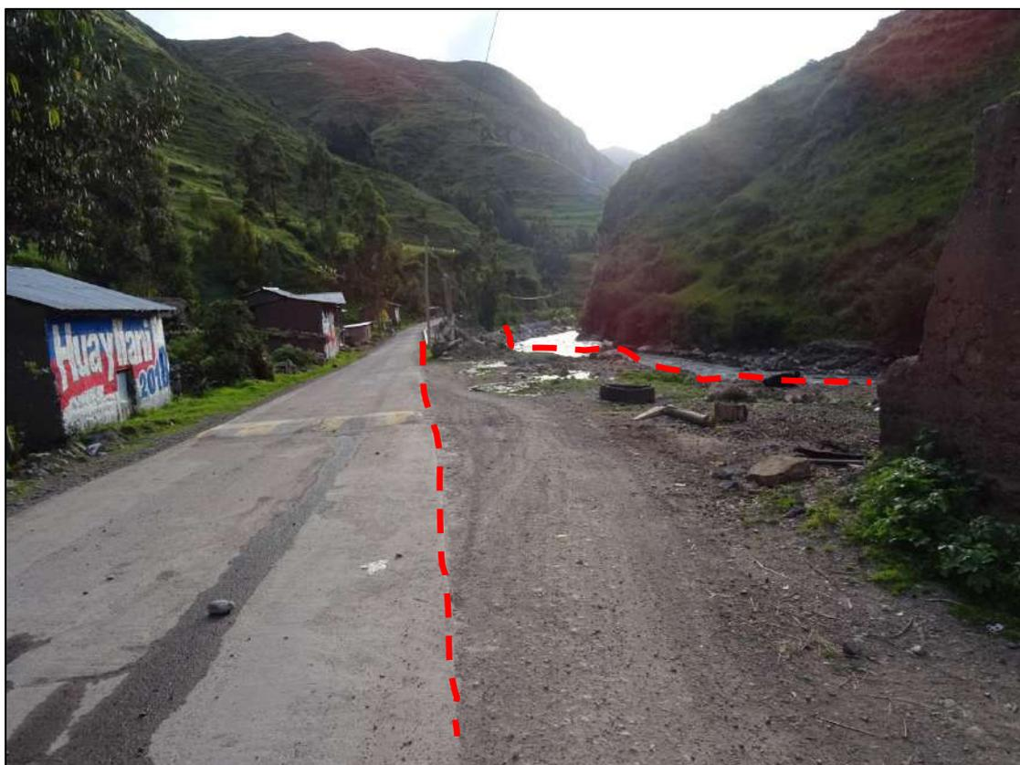
Fotografía 2 – C.P. Anchaclla, se aprecia sector impactado por Niño Costero 2017. Este sector fue erosionado por el río, parte de la vía carcomida y 6 viviendas colapsaron (según catastro de daños de COFOPRI).
