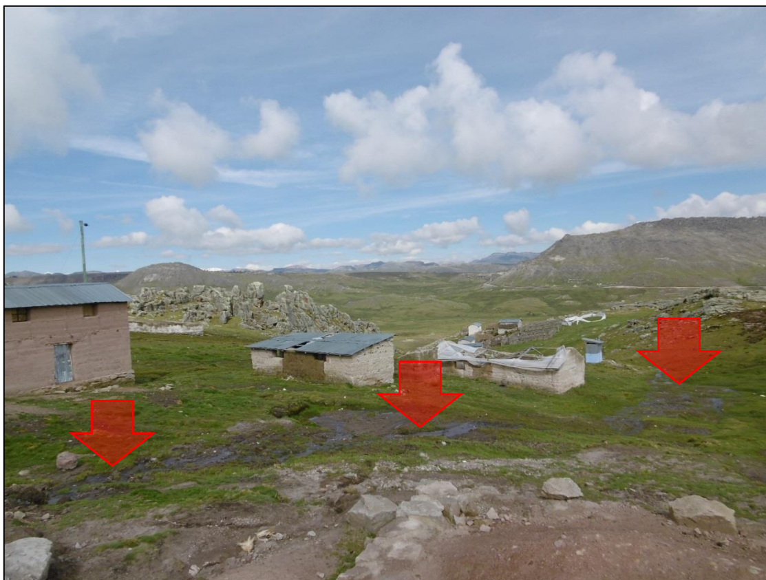
Fotografía 1 – C.P. Socclabamba se aprecia escorrentías circulando libremente entre las viviendas
