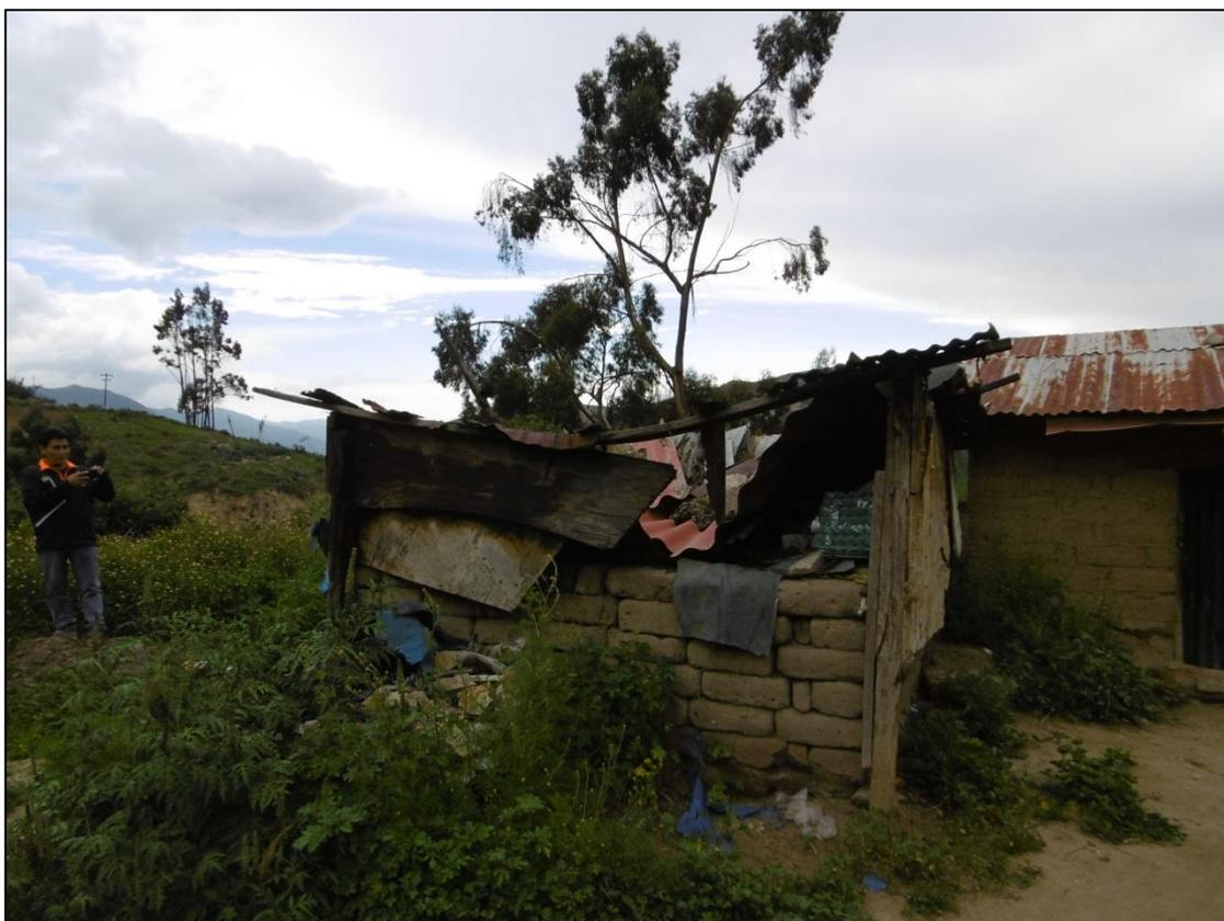
**Fotografía 3 – Vivienda colapsada a consecuencia de las lluvias intensas.**
