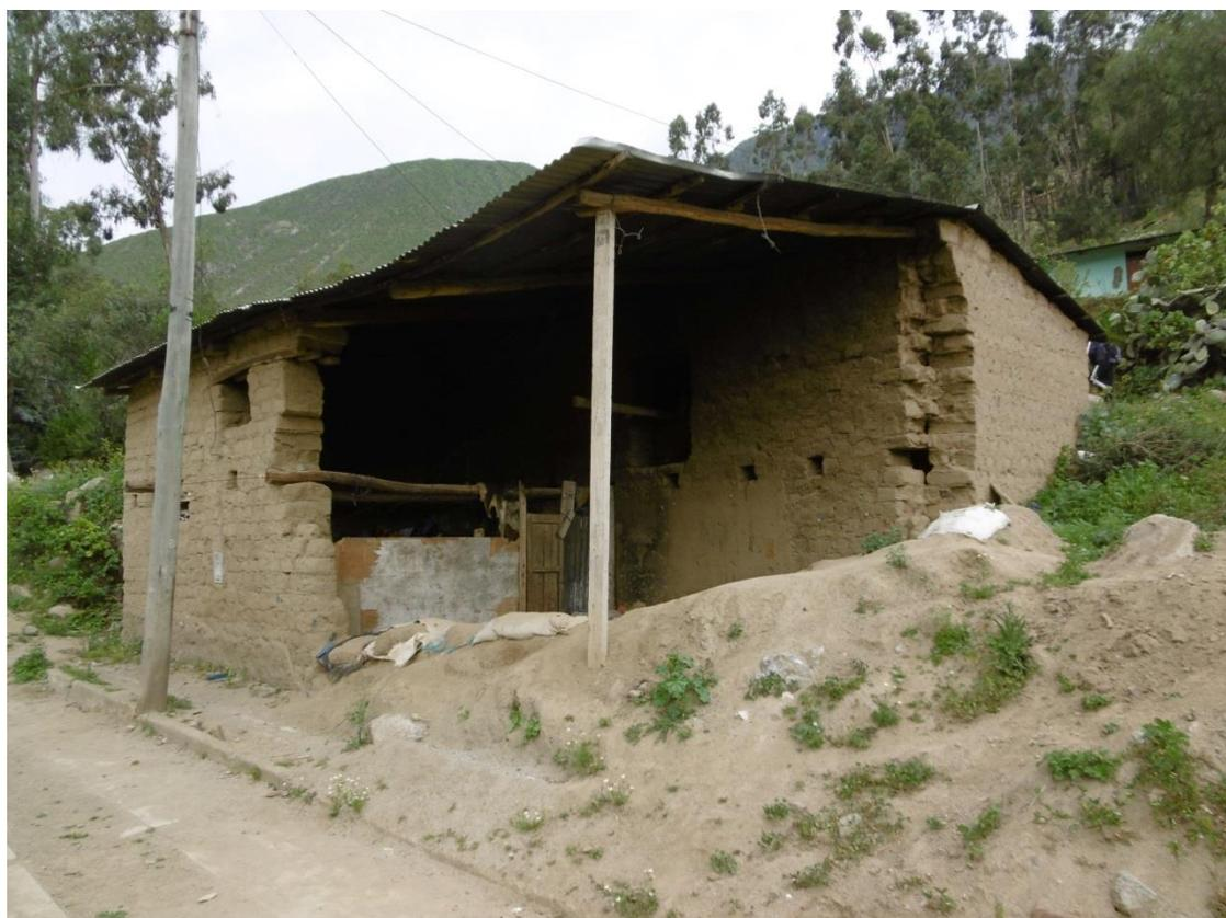
**Fotografía 4 – Vivienda colapsada a consecuencia de las lluvias intensas.**
