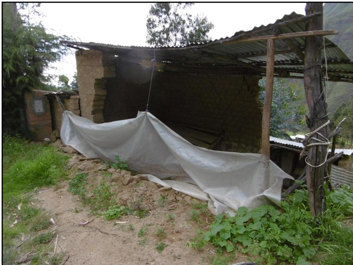
Fotografía 1 – Vivienda colapsada a consecuencia de las lluvias intensas.
