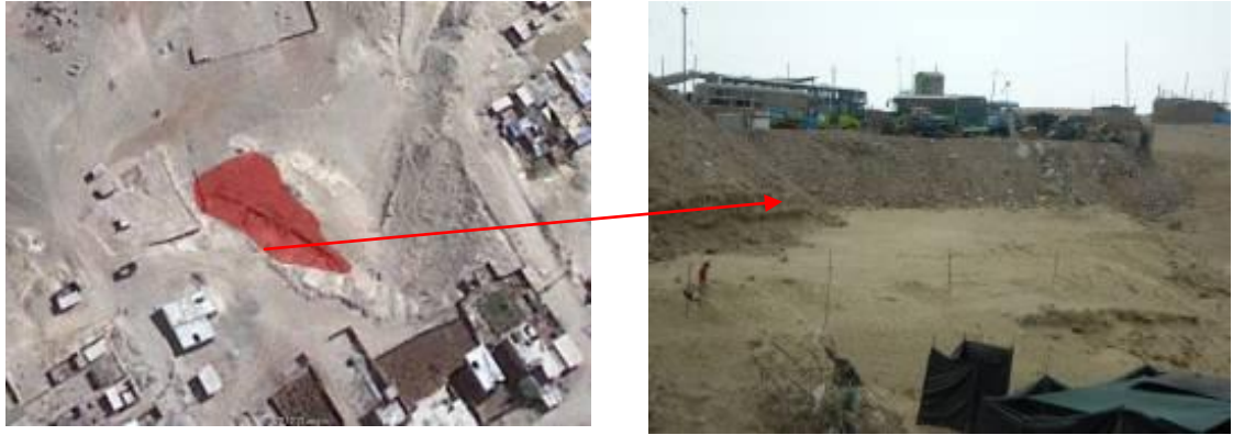
Foto 12. Al norte del área urbana de San Clemente se han identificado rellenos antrópicos que alcanza una altura de más de 1 m de espesor.
