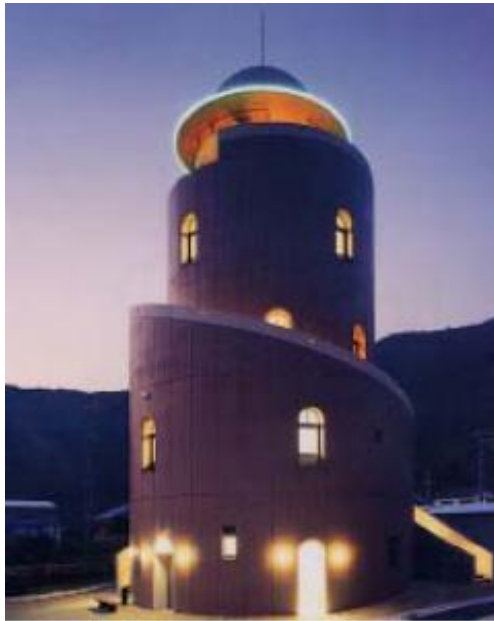
Figura 16. Torre de evacuación prefectura de Mie, Japón.
