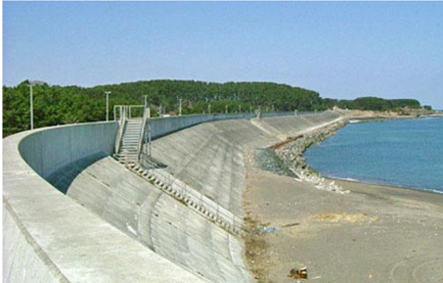
Figura 17. Muro de defensa en uso como protección frente a tsunamis en las costas de Japón.
