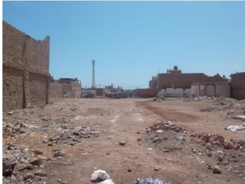
Foto 15. Viviendas que colapsaron durante el terremoto de Pisco (Agosto del 2007) fueron cimentadas en zona de rellenos heterogéneos, parte de sus escombros aún pueden ser vistos en la actualidad.
