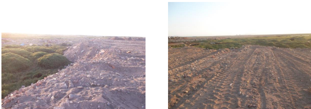
Foto 6. Escombros y materiales dispuestos frente al litoral marino de la ciudad de Pisco con el fin de ganar terreno al suelo pantanoso.
