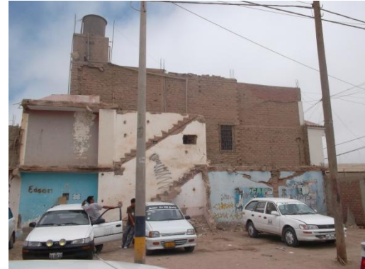
Foto 15. Viviendas que colapsaron durante el terremoto de Pisco (Agosto del 2007) fueron cimentadas en zona de rellenos heterogéneos, parte de sus escombros aún pueden ser vistos en la actualidad.
