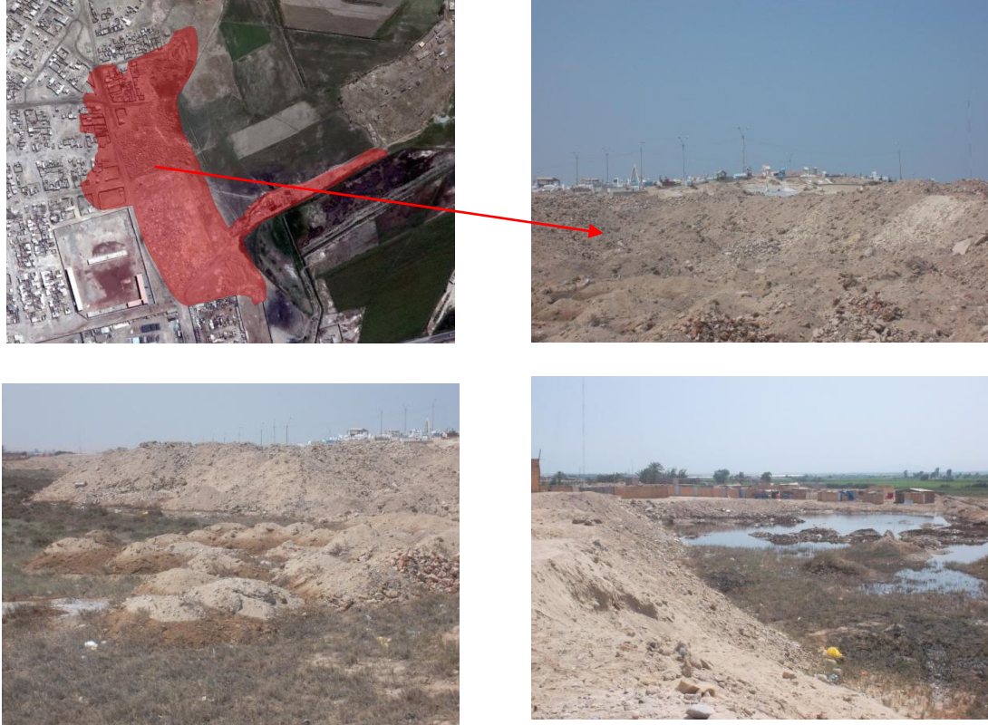
Foto 13. Botadero clandestino localizado frente al cementerio de la ciudad de San Clemente, parte de estos residuos yacen sobre un área pantanosa.
