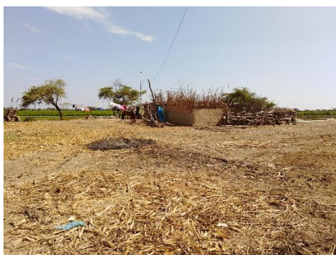
Vivienda de caña y adobe en paredes y techo
