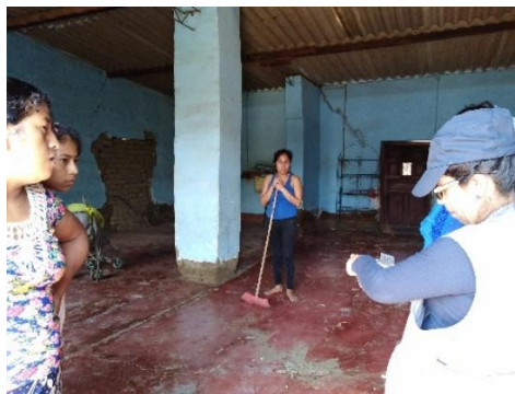
Vivienda inhabitable con gran afectación en elementos estructurales
