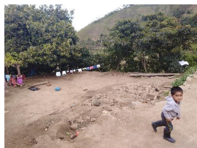
Vivienda fue totalmente colapsada
