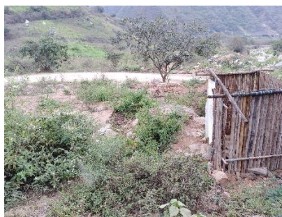
Vivienda casi totalmente colapsada por flujo de detritos
