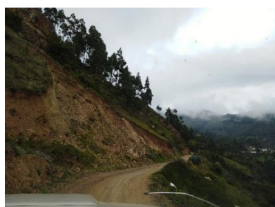
Vista de huellas de terreno cedido a causa de lluvias intensas, así como la fuerte pendiente
