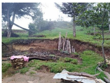
Varios tramos de terreno cedido por saturación de suelos
