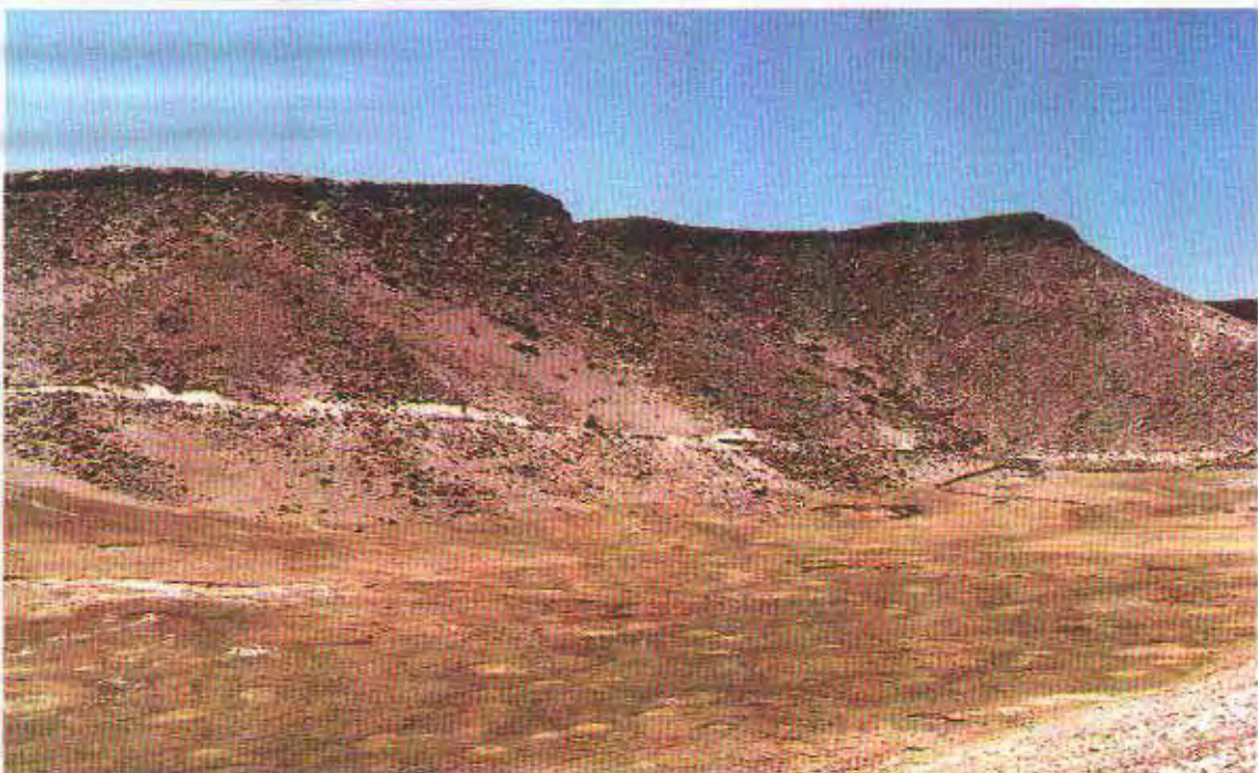
Foto N° 26. Desprendimiento de rocas. Carretera Arequipa-Puno, sector Paty-Pampa Confital, cabecera de la quebrada Jatun Orco.
