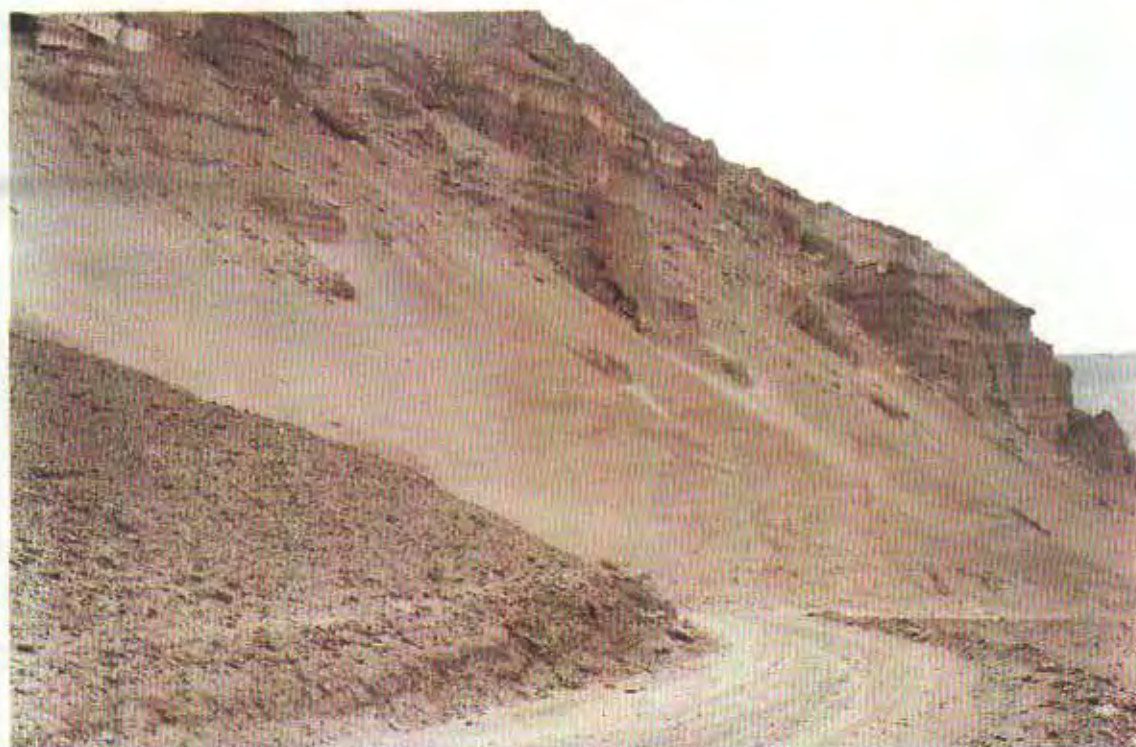
Foto N° 18. Derrumbes en el sector Valencia Grande (valle del río Vitor), sobre rocas de la Fm. Moquegua que compromete a la trocha carrozable.
