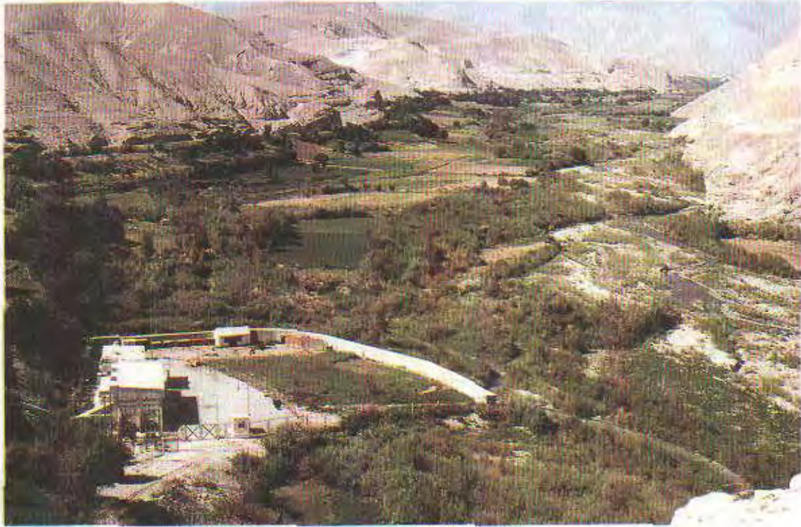
Foto N° 14. Zona de inundación que puede comprometer la C.H. de Quilcapampa, río Sihuas.
