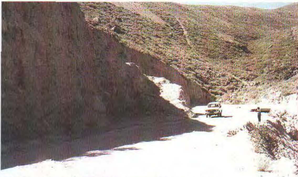
Foto N° 8. Flujos de barro (COF). Corte en la carretera Baños de Jesús-Chihuahua.
