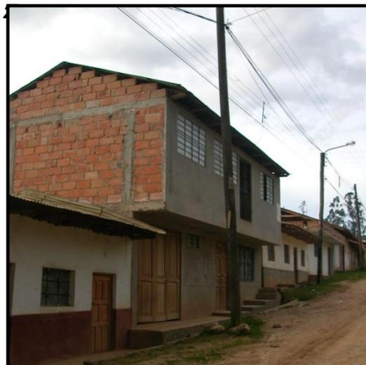
Foto. Vista característica sistema constructivo, véase esbeltez de muros laterales sin vigas de amarre.
