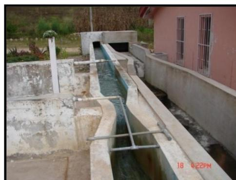
Foto: Canal de transición para mezcla rápida al inicio del proceso del tratamiento de agua potable.
