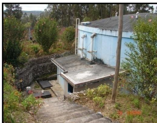
Foto: Reservorio de almacenamiento de agua 935 m<sup>3</sup>, ubicado en la planta de tratamiento.
