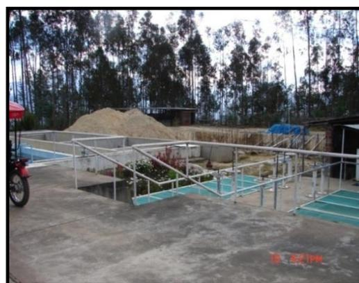
Foto: Área de Filtros dentro del proceso del tratamiento de agua potable
