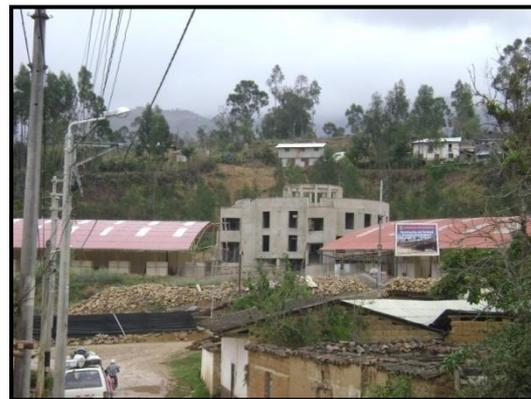
Foto: Terminal Terrestre, véase suelo disturbado por corte superior ladera, con amenaza de deslizamiento
