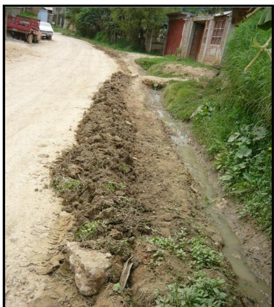
Foto: Zanjas artificiales para evacuación desagües, en calle prolongación Ortiz Arrieta
