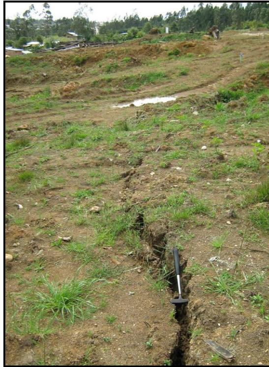
Foto. Sector Sur de la Urb. Magisterial, grietas tensionales producto de la sobre saturación de suelos por aguas pluviales
