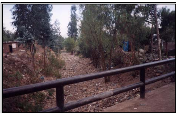
Río Opancay, obsérvese viviendas en ambas márgenes muy cerca del cauce principal y prácticamente ubicadas en el cauce de avenidas por lo que se encuentran expuestas a inundaciones y procesos erosivos por el flujo de agua del río en época de lluvias intensas. En la margen derecha se cuenta con un cerco rústico de piedra que no impediría los daños en época de avenidas.
