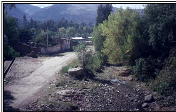
Parte baja del río Huanta en donde se observa que las viviendas se encuentran casi al nivel del fondo del cauce, requiriéndose la construcción de diques de defensa
