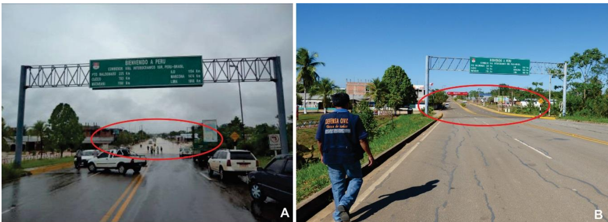
Foto 15. A) Inundación del año 2012, Av. León Velarde afectado (tomado por INDECI). B) Vista del desnivel de la carretera interoceánica, parte del casco urbano de la ciudad de Iñapari, próxima al puente internacional (Av. León Velarde) se encuentra por debajo del área que ocupa el meandro del río Acre, lo cual favorece el embalsamiento en la época de lluvias intensas.
