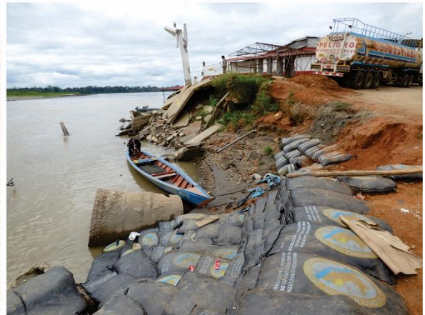
Foto 9. Vistas del Puerto Laberinto debido a la erosión fluvial de 200 m de longitud, colapsó un grifo, se ha colocado costales de arena a fin de mitigar dicho proceso.
