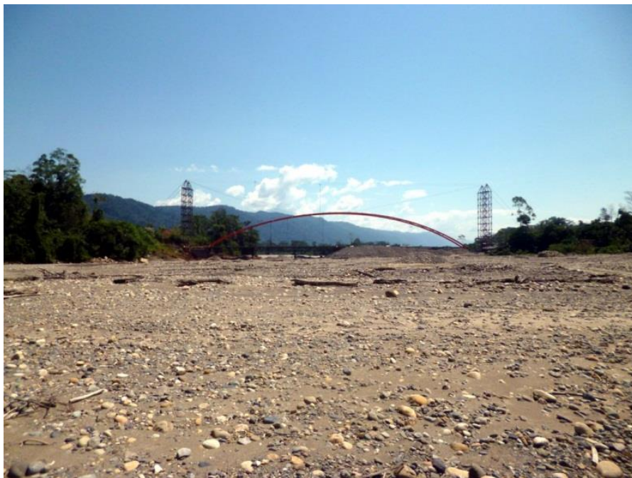
Foto 19 Vista aguas abajo del río Carbón, se puede observar el nuevo puente vehicular que se está construyendo, este debe contar con buenas defensas rivereñas en los estribos del puente, los cuales deben estar muy bien cimentados para resistan los caudales que discurren por el río.
