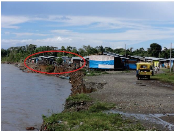
Foto 10. Vistas del sector Sarayacu, como producto de la erosión fluvial-inundación colapsaron 27 viviendas, la inundación llegó hasta el sector Virgen de la Candelaria, Km 338 de la carretera Interoceánica.
