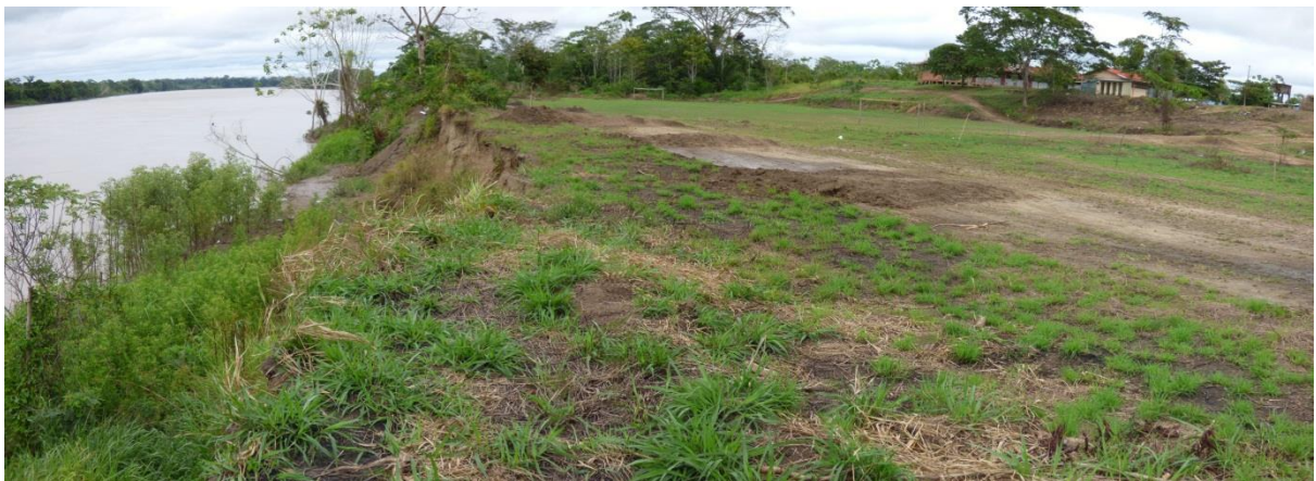
Foto 4. Erosión fluvial en la margen derecha del río Madre de Dios, sector San Juan Cachuela.
