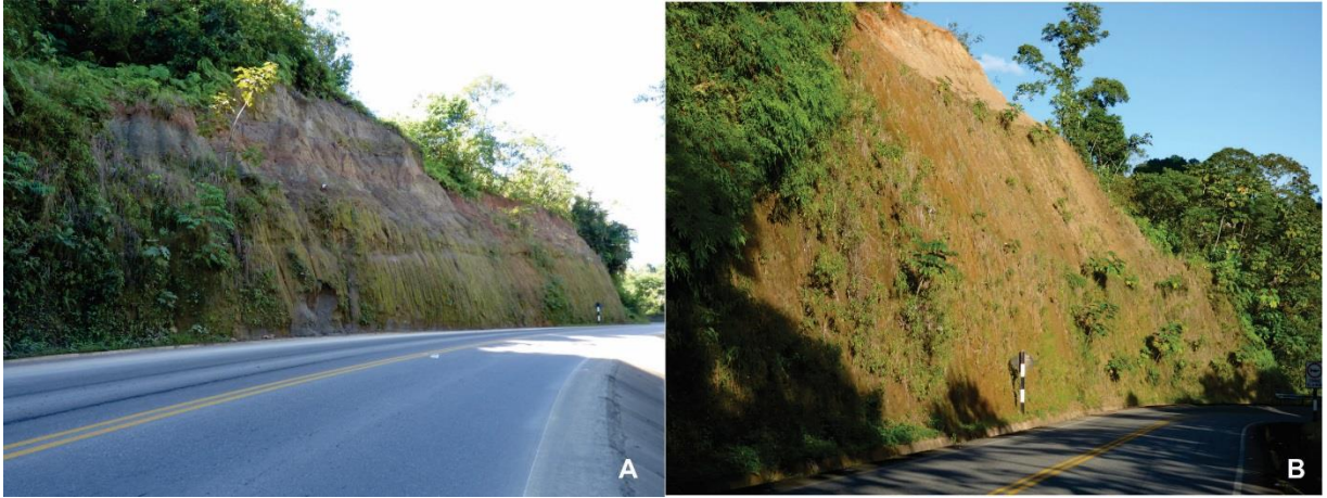
Foto 12. Derrumbes en los km 287+830 de 80 m de longitud y 15 m de alto (A), km 277+000 con presencia de filtraciones en talud superior de la carretera interoceánica, sector Santa Rosa (B).
