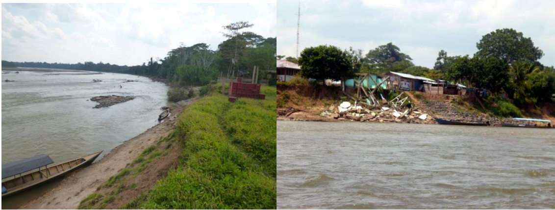
Foto 18. Proceso erosivo en la margen izquierda del río Madre de Dios en el distrito de Boca Manú, produjo la pérdida de terrenos en la plaza principal y la destrucción de la comisaría del distrito.
