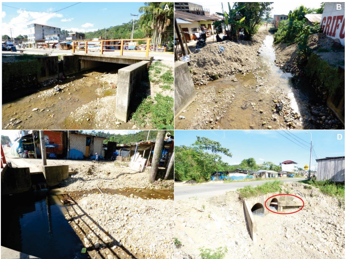
Foto 13. Tramo de carretera interoceánica es cortado por quebradas, a consecuencia de lluvias intensas discurren huaycos. En enero del 2014 se desbordó afectando viviendas que se encuentran en ambas márgenes del jr. Masuko del poblado de mismo nombre; los colectores de drenaje pluvial también desembocan en estas quebradas (A, B y C). En el km 261+863 se ha colocado dos alcantarillas, por donde pasa la tubería de agua potable marcado por el círculo de color rojo (D).
