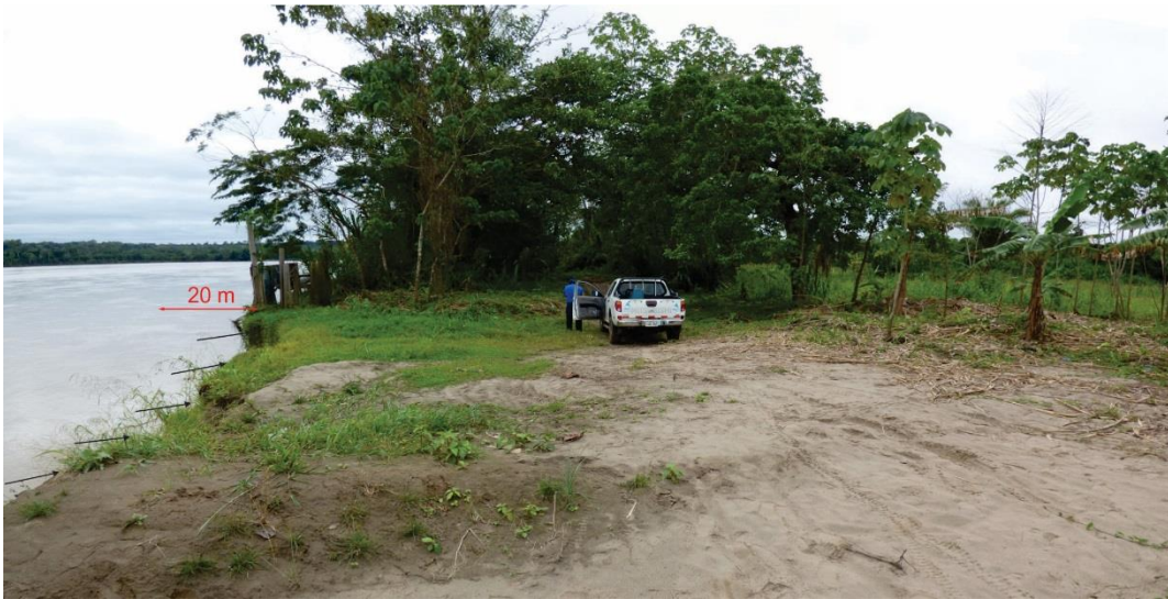
Foto 6. Erosión fluvial en la margen derecha del río Madre de Dios, produjo la pérdida de 20 m de ancho x 600 m de longitud y destruyó extensas áreas de cultivo en el sector Boca Piedras.
