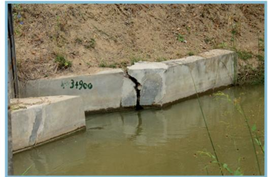
*Canal de riego en condiciones de fragilidad y expuesto a probables deslizamientos.*
