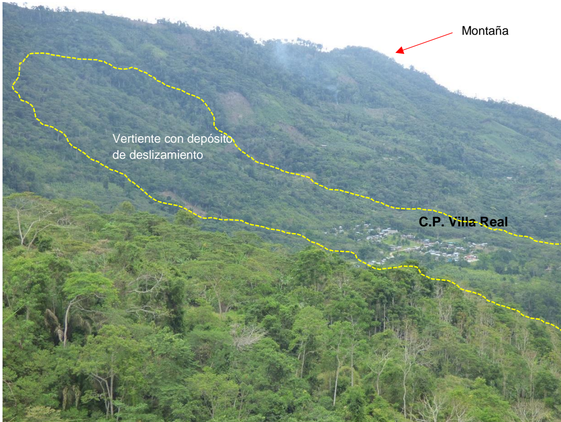
Foto 01: Vista panorámica de la vertiente con depósito de deslizamiento (línea punteada a amarilla) sobre la cual se ubica el centro poblado Villa Real y de las montañas que rodean dicho centro poblado
