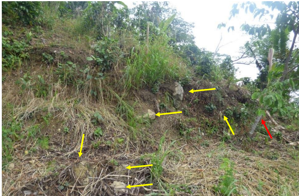
Foto 02: Depósito coluvio-deluvial, producto del deslizamiento, con bloques de calizas y calcoarenitas (flechas amarillas). Como también se aprecia árbol ligeramente inclinado (flecha roja).
