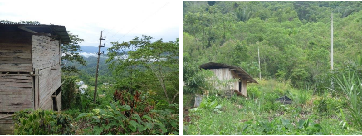
Fotos 6 y 7: Postes inclinados producto del terreno inestable
