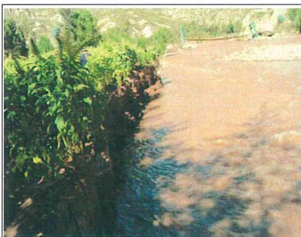
Se observa que el terreno agrícola se está erosionando y socavando a través de tiempo por el flujo dinámico del río Antabamba de la margen derecha.
