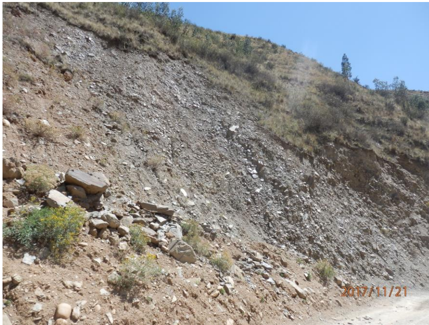
Fotografía 1. Vista tomada con dirección noroeste, se observa deposito coluvial formado por material limo arcillosa (coordenadas 240903 E; 8427250 S)
