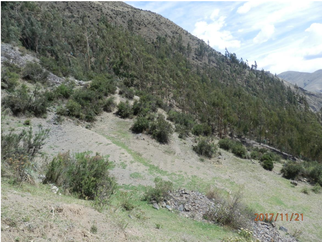
Fotografía 5. Ladera del cerro Vizcachani con pendiente promedio de 30°, se observa eventos de tipo deslizamiento, derrumbes y reptación.
