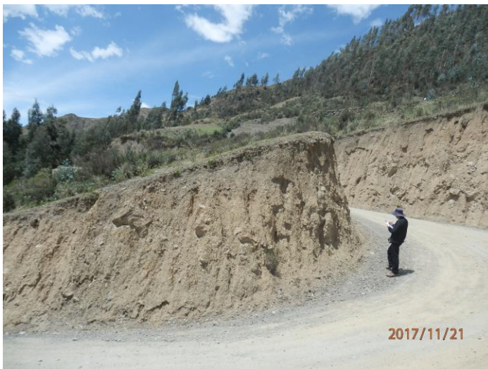
Fotografía 4: Suelo incompetente, medianamente consolidado, formada por gravas y arenas con matriz limosa.
