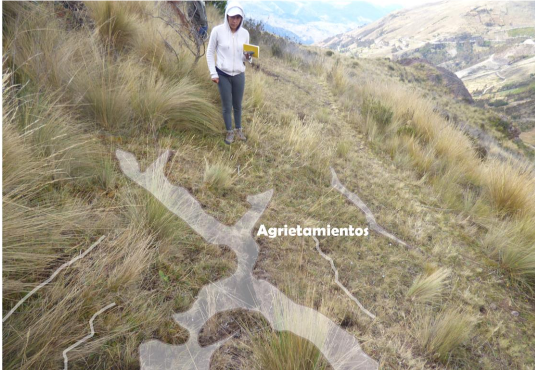
Foto 5: Agrietamientos paralelos a la escarpa principal de deslizamiento.
