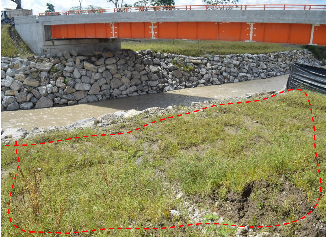
FOTO N° 06: Se muestra los depósitos aluviales, actualmente, sobre estos depósitos sobreyace el puente nuevo en el sector José Olaya (línea roja).
