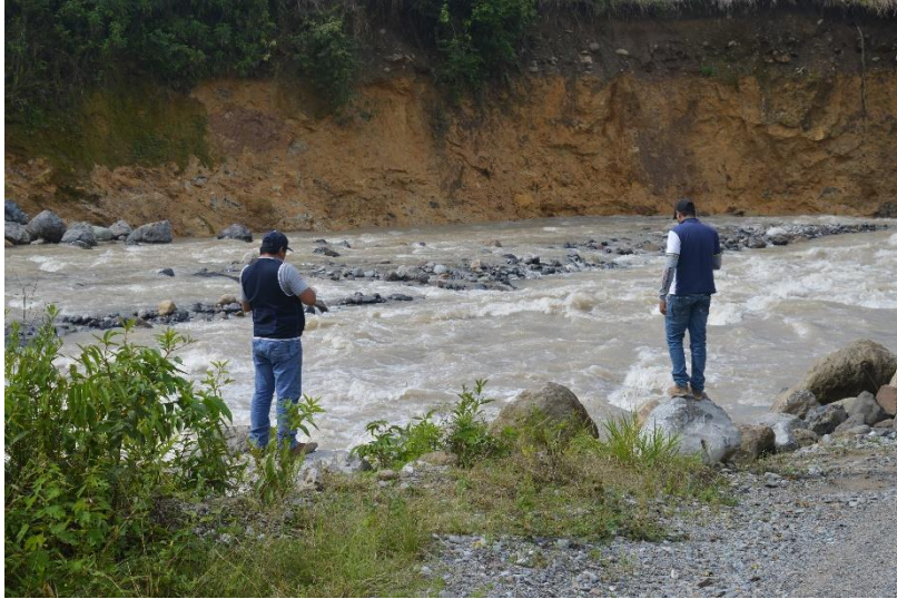
Foto N ° 01, 02, 03: Áreas afectadas por erosión del río Yuracyacu
