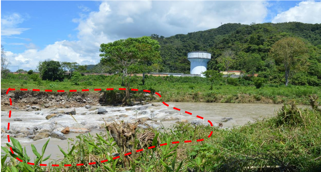
FOTO N° 19: Se muestra la erosión fluvial en ambas riberas del río Yuracyacu (referencia, bocatoma del canal de irrigación michuco).
