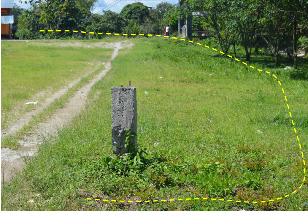
FOTO N° 10: Se muestra la llanura de inundación en el puente que conduce al colegio Manuel Hidalgo, Nueva Cajamarca.
