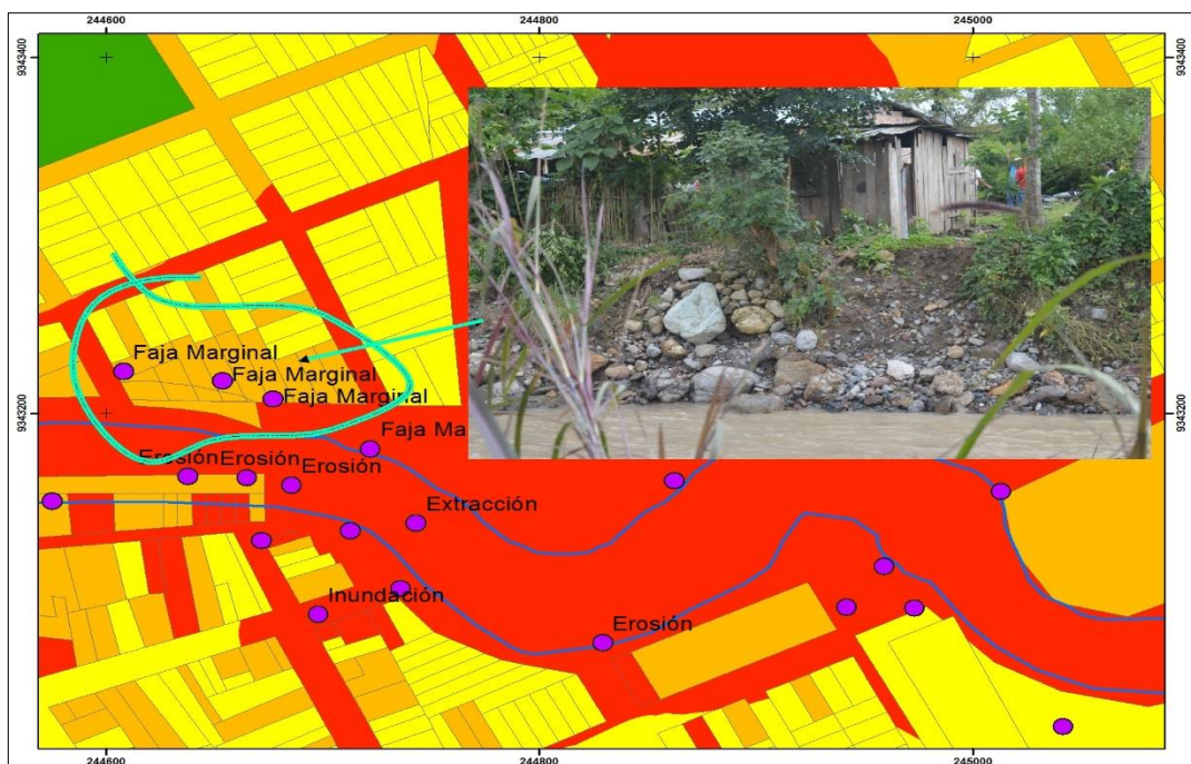
FOTO N° 20: Se muestra las viviendas que actualmente ocupan la franja marginal (244653.628 E, 9343218.255 N), asimismo, se muestra el grado de erosión que avanza en un nivel de recuperación de su cauce principal del río Yuracyacu.
