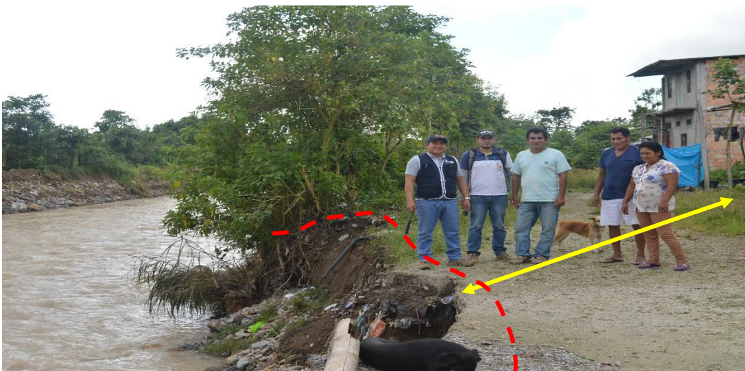
FOTO N° 14: Se muestra el nivel de erosión alta (244637.568 E, 9343164.532N), distancia del río a las viviendas de 3 metros aproximadamente (línea amarilla).
