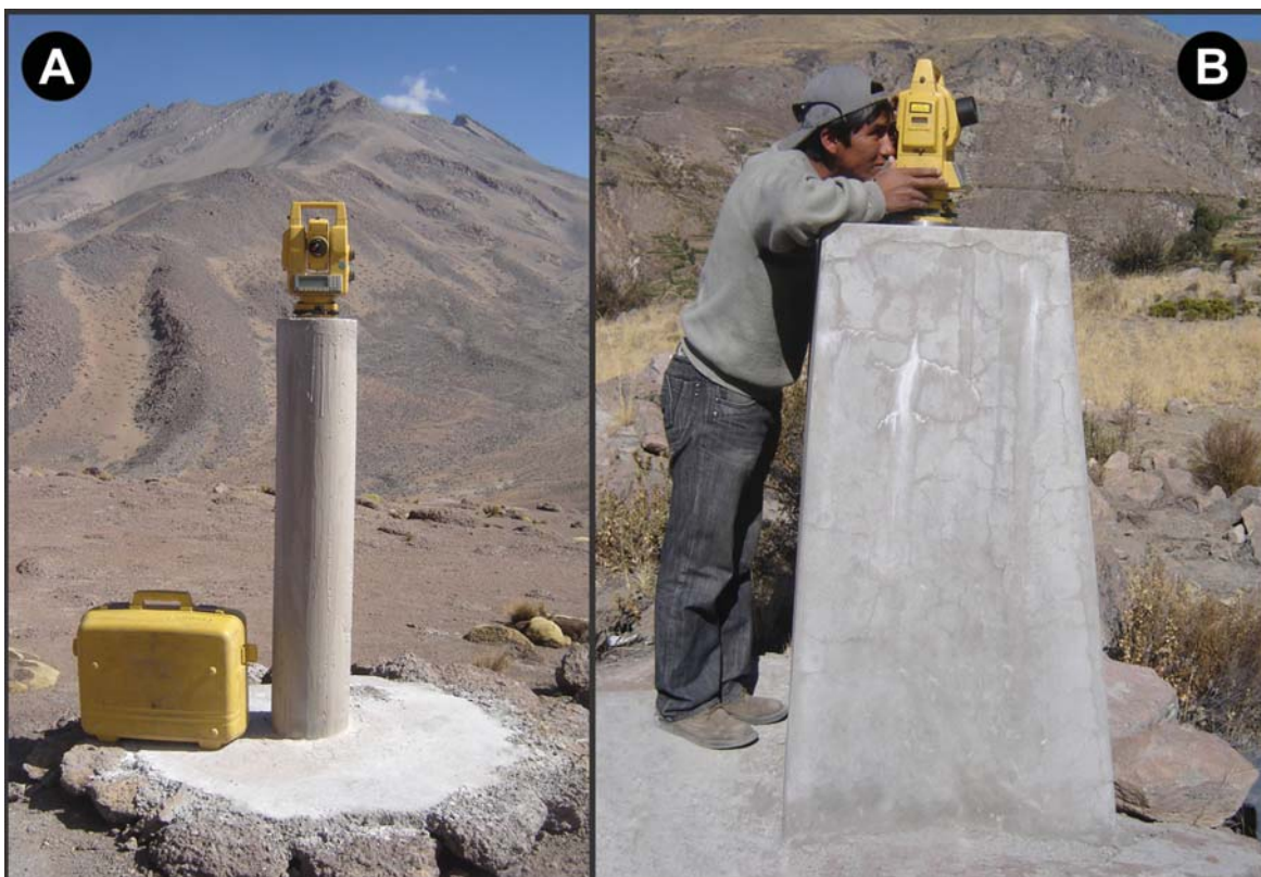
Figura 6.2 Fotos de los pilares de concreto construidos para el monitoreo geodésico en el volcán Ubinas. A) UBCH, es un pilar cilíndrico construido sobre afloramiento rocoso, B) UBQE, pilar cuadrado construido sobre suelo blando poco profundo.
