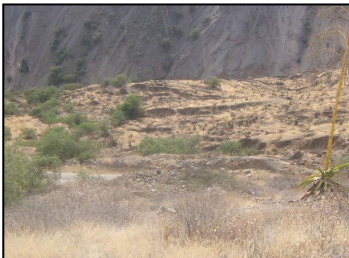
Foto 21.- Deslizamiento ubicado en la carretera Tumac-Llocche, se aprecian los agrietamientos.
