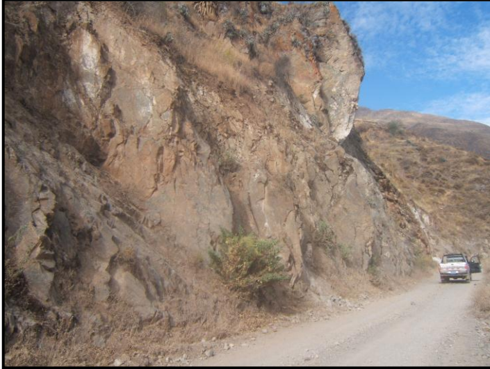
Foto 9.- Afloramiento de rocas volcánicas, derrames lávicos andesíticos. Sector carretera Tumac-Llocche.
