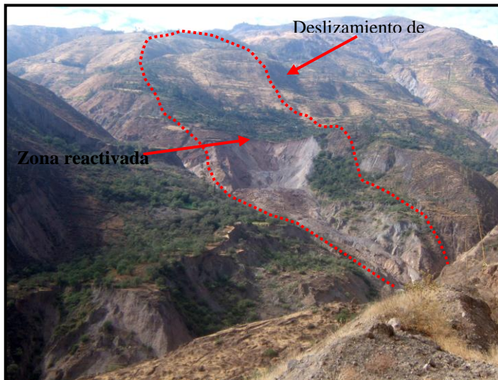
Foto 11.- Vista panorámica del deslizamiento de Llocche.
