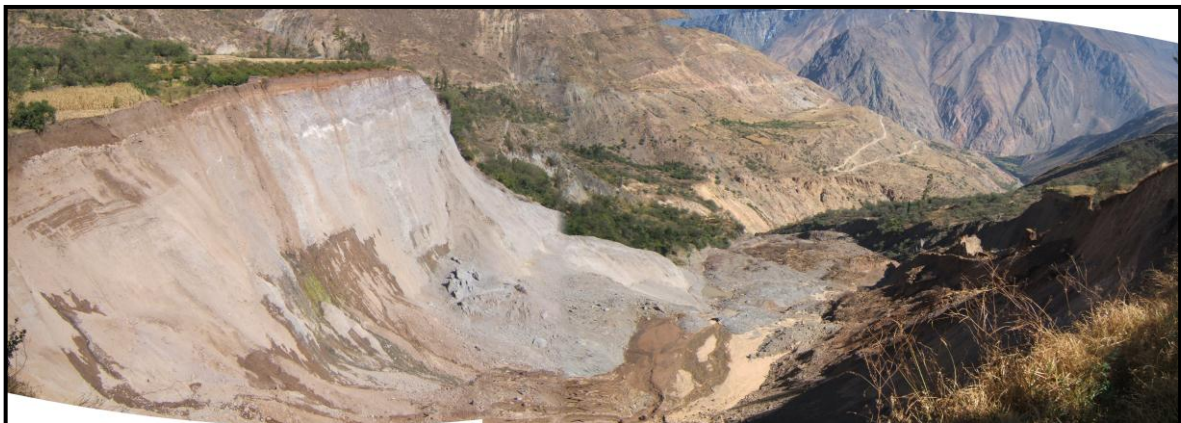
Foto 16.- Vista del lado suroeste del deslizamiento, en la escarpa se aprecian zonas con filtraciones de agua y parte del flujo
