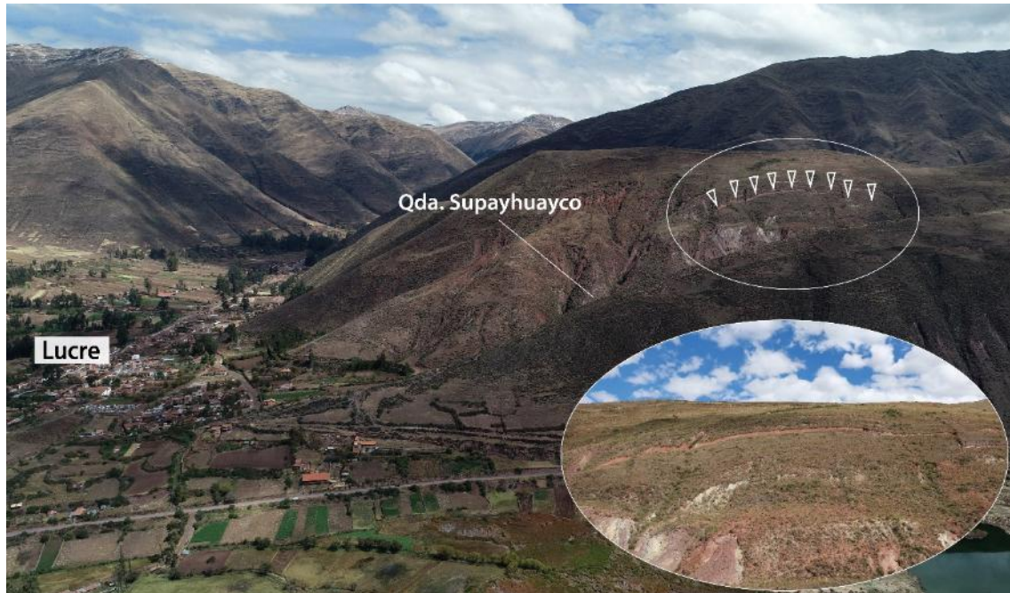
Figura 3. Vista al suroeste del deslizamiento en la quebrada Supayhuayco, distrito de Lucre.
