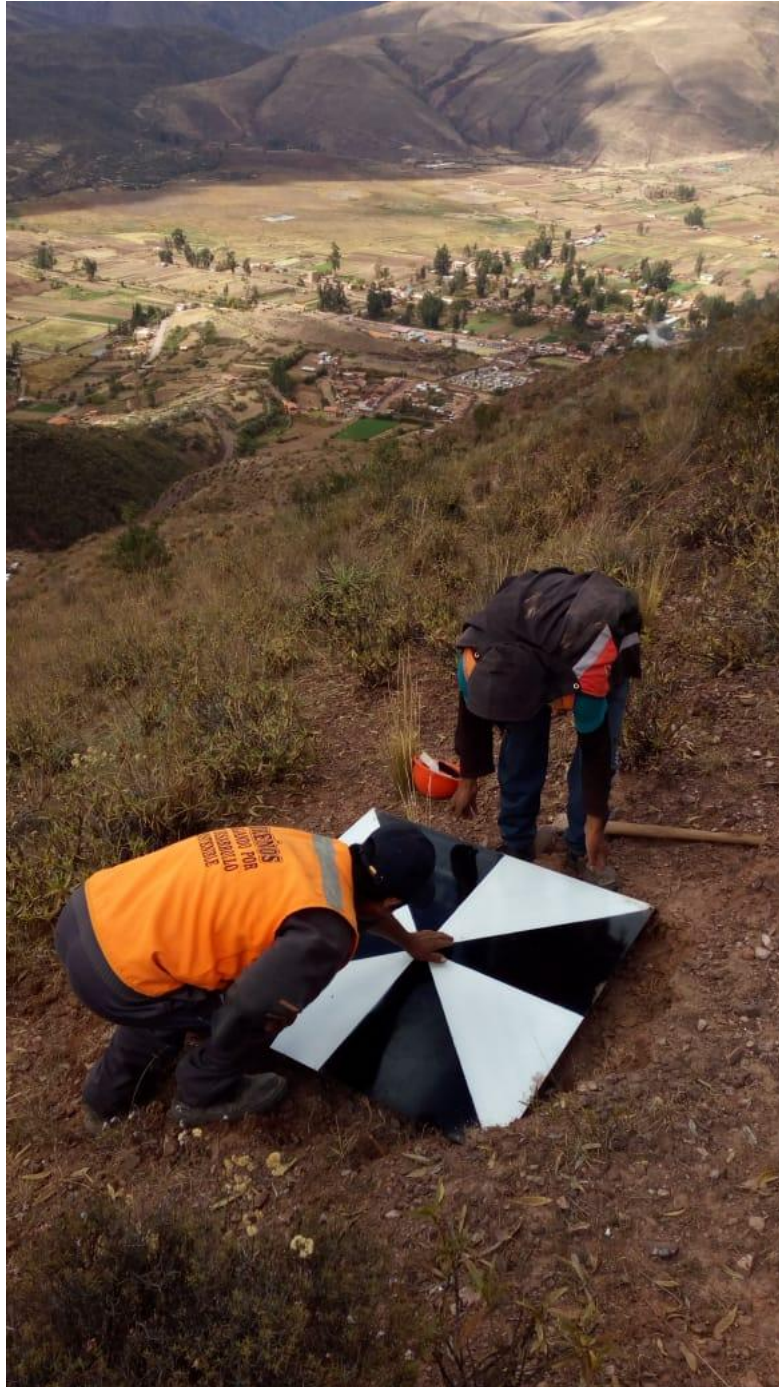
Foto 1. Instalación de puntos de control para monitoreo del deslizamiento con GPSD.
