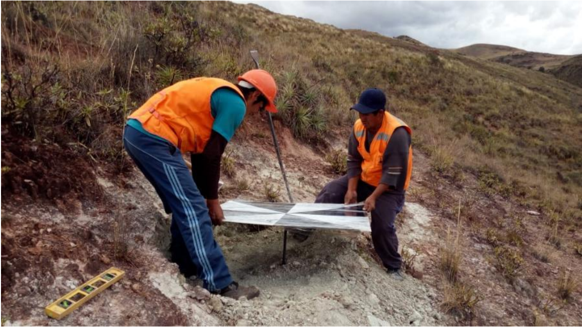
Foto 2. Instalación de puntos de control para monitoreo del deslizamiento con GPSD.
