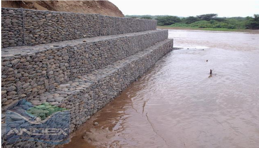
Foto 16: Ejemplo de defensa ribereña, tipo gavión.
