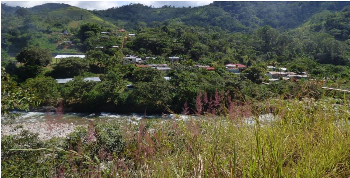
Foto 4: Terrazas aluviales bajas, zona susceptible a inundaciones. Centro poblado de Unión Progreso.
