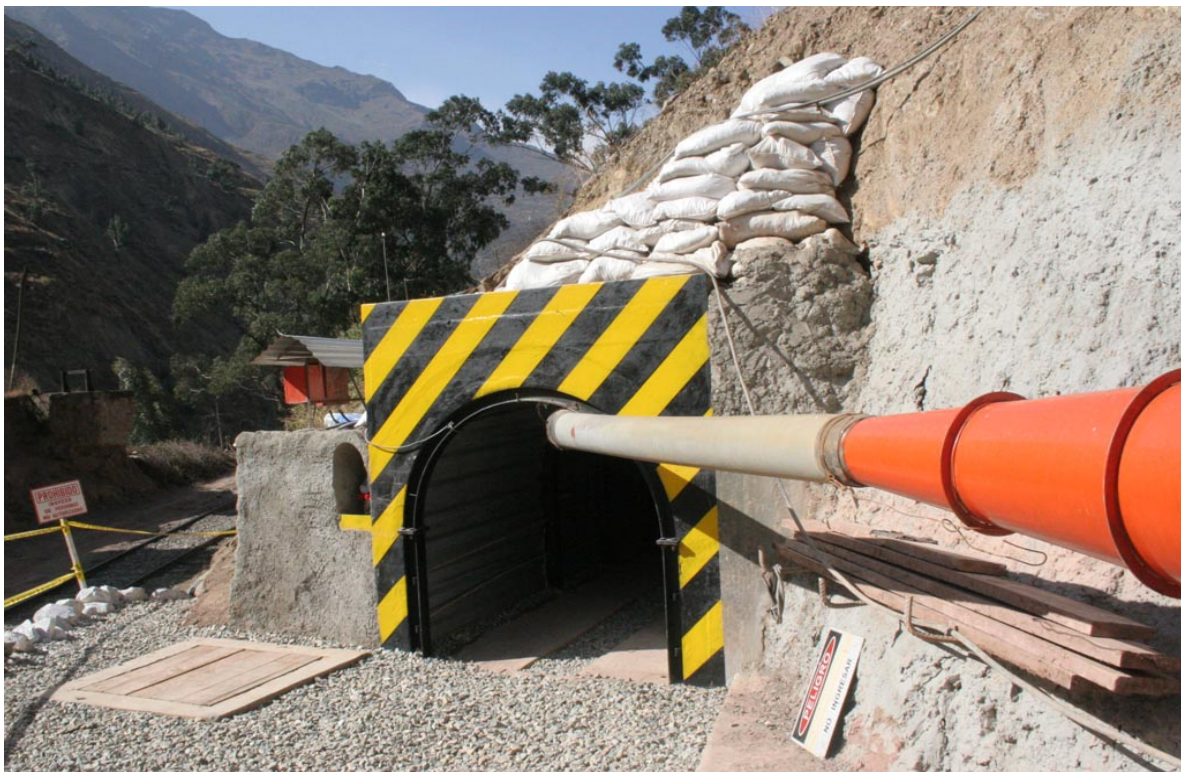
Construcción de Túnel de drenaje: Foto: Google
