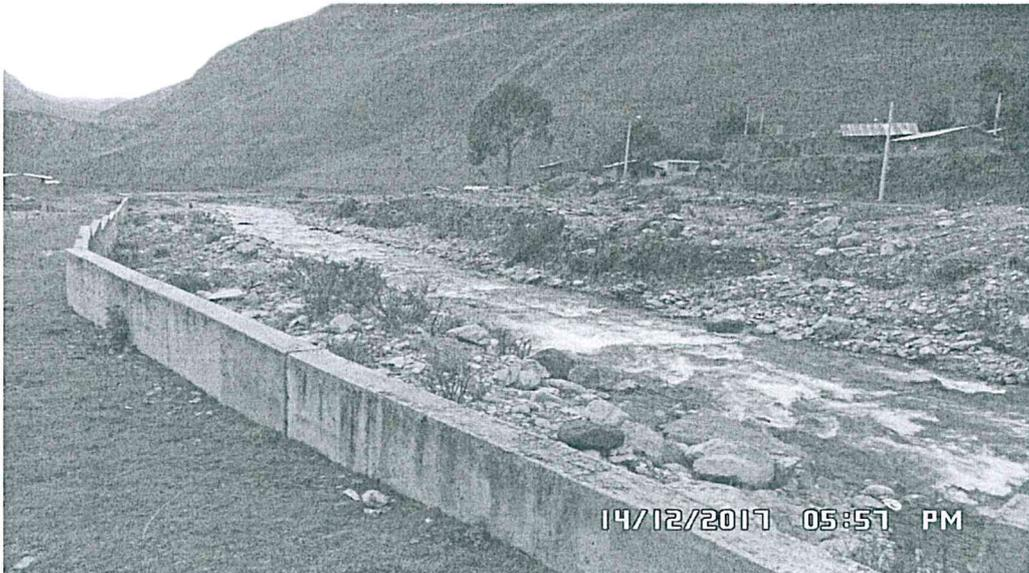
Fotografía 05: Donde se aprecia la defensa ribereña en la margen izquierda del río Carhuacocha
