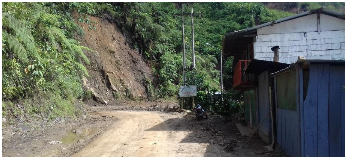
Foto 17: Deslizamiento traslacional, la ocurrencia de la misma destruyó dos viviendas (529561, 8745320).
