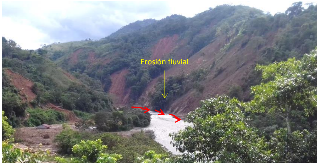
Foto 22: Derrumbe a la margen izquierda del río Pampa Hermosa originados por erosión fluvial. Foto Municipalidad de Pampa Hermosa.
