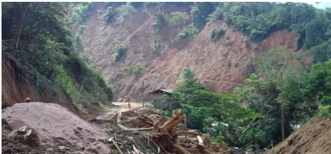
Foto 24: Vista de material movilizado por los movimientos en masa. Foto Municipalidad de Pampa Hermosa. Foto Municipalidad de Pampa Hermosa.
