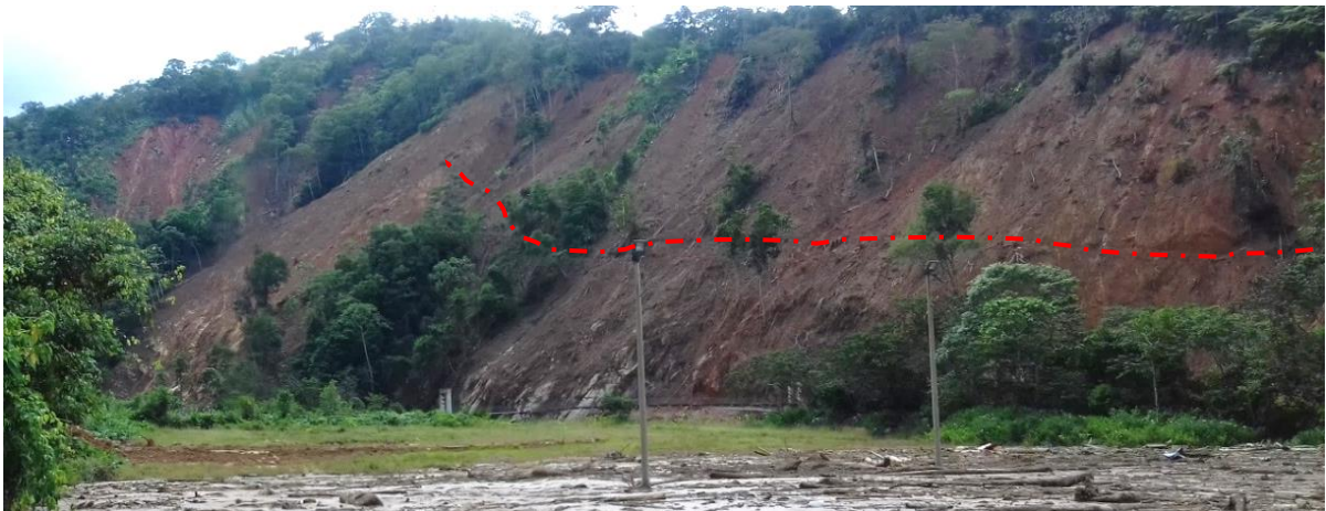
Foto 21: Se observan derrumbes hacia la margen izquierda del río Pampa Hermosa, que afectaron la vía de acceso a los centros poblados aledaños a San Dionicio (Con líneas entrecortadas se muestra trazo de carretera), Foto Municipalidad de Pampa Hermosa.
