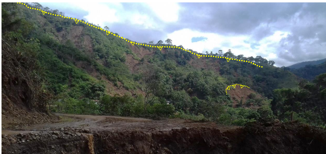
Foto 15: Escarpe de un deslizamiento. Foto Municipalidad de Pampa Hermosa.
