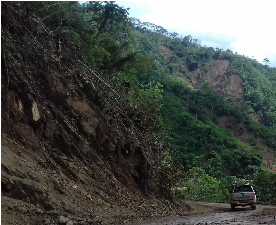
Foto 1: Afloramiento de roca intrusiva en la carretera rural del sector San Dionicio.
