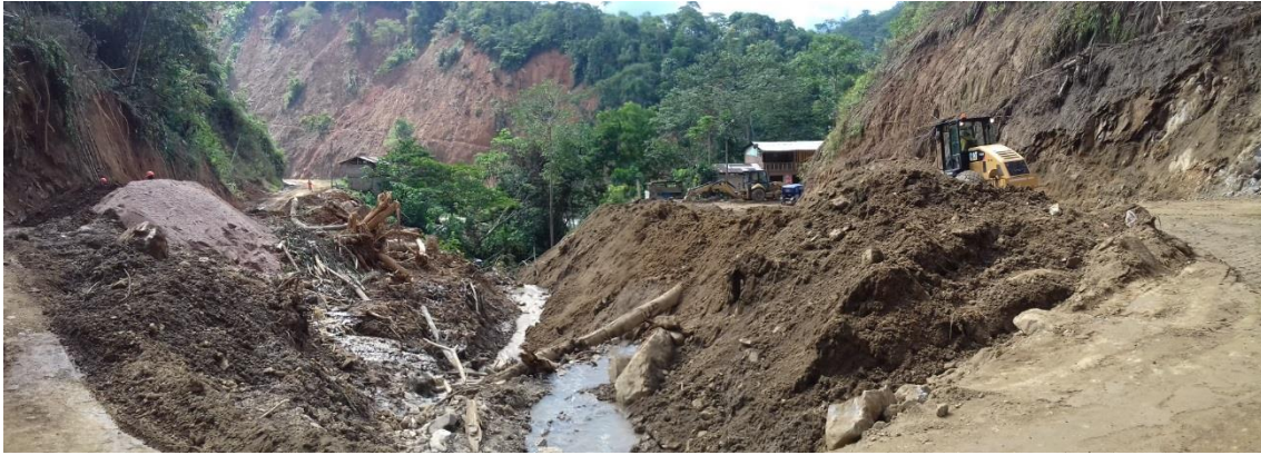
Foto 11: Carretera antigua Satipo-Huancayo totalmente afectada por el flujo de lodo. Foto Municipalidad de Pampa Hermosa 2016.
