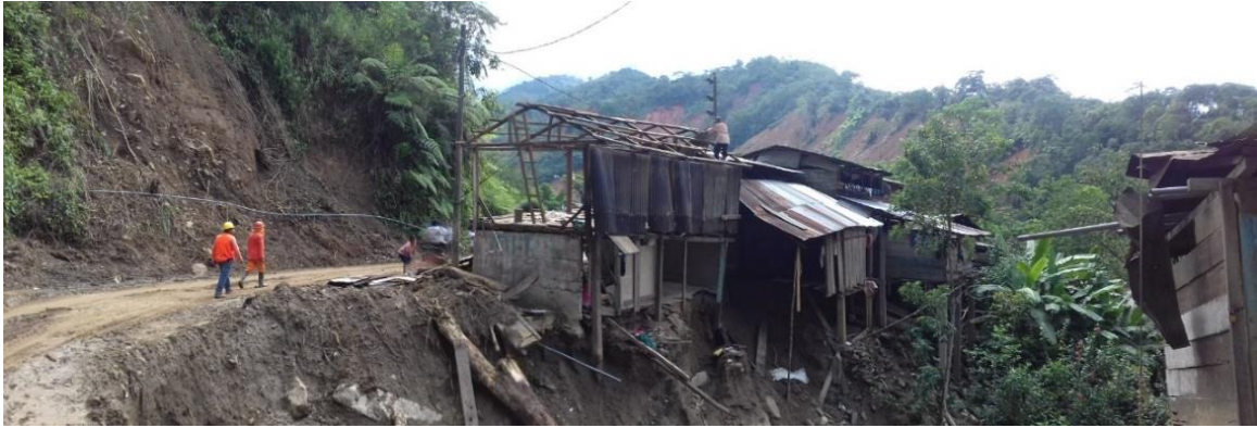
Foto 18: Viviendas destruidas por la ocurrencia de un deslizamiento y flujo de lodo. Foto Municipalidad de Pampa Hermosa.
