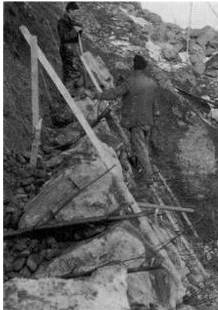
**Fotografía 15.** Muro de piedra recubierto de vegetación durante la construcción. Obsérvese que las ramas llegan al suelo del fondo.
