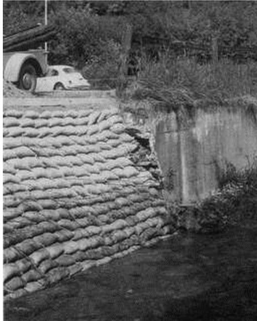
**Fotografía 17** Gaviones flexibles de tipo de saco combinados con plantas leñosas enraizadas para reforzar una margen erosionada.
