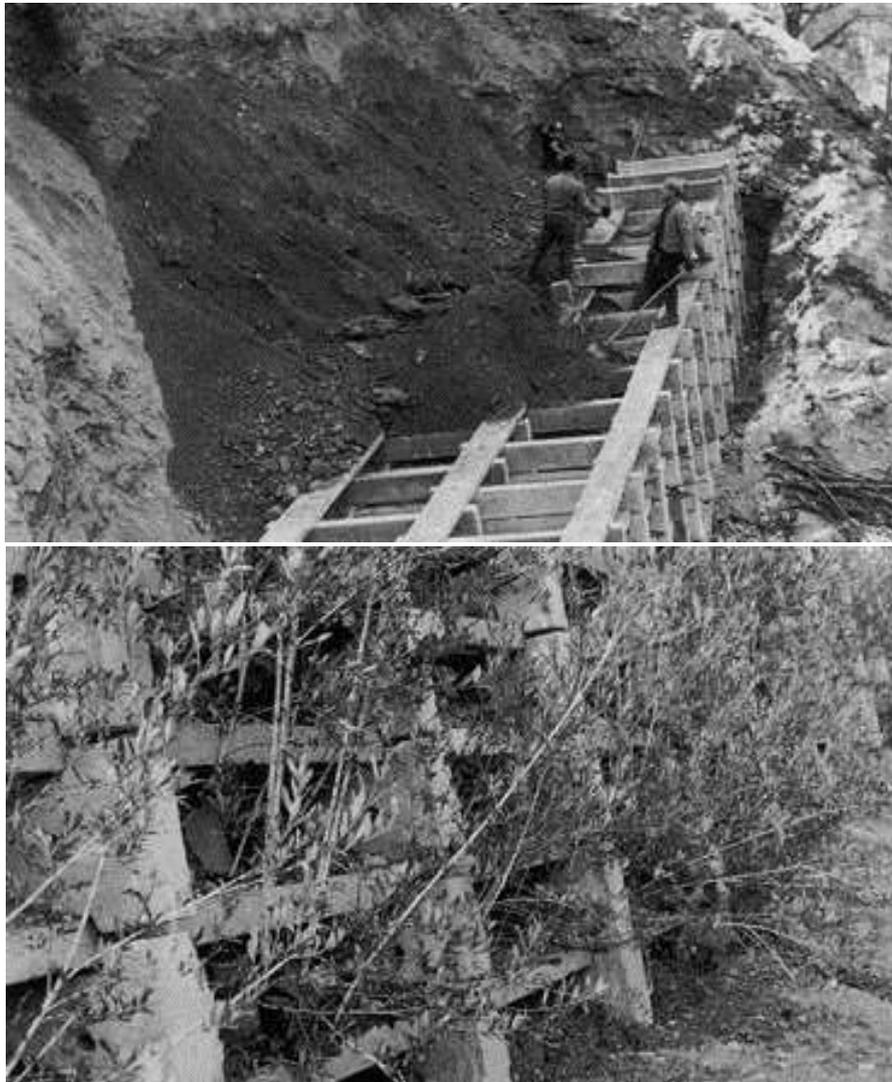
**Fotografía 14** Muro de sostenimiento de hormigón con lechos de ramas. Arriba, durante la construcción. Abajo, después de un año.
