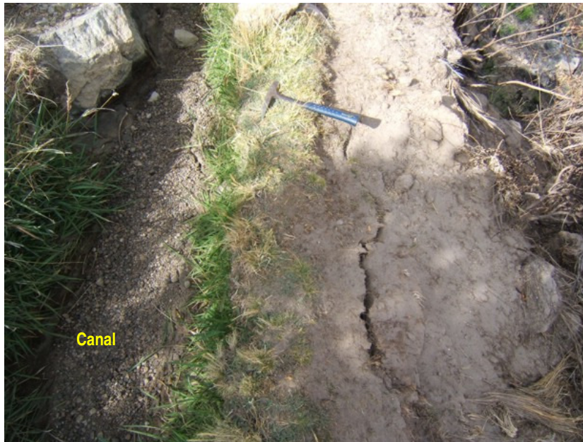
Fig. 3.5: Agrietamientos a lo largo del cauce del canal que poseen de 2 a 3 cm de abertura y más de 4 m de largo.
