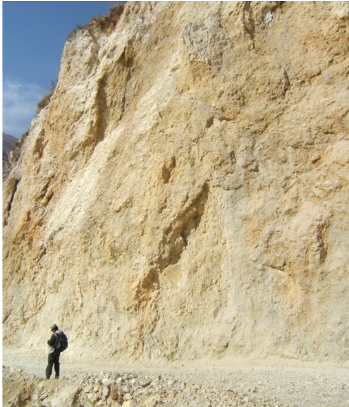
Fig. 3.21: Derrumbes y desprendimientos de rocas en la carretera Calacoa – San Cristóbal, cuyos restos fueron limpiados al día siguiente de ocurrido el sismo del 01 de octubre del 2005.
