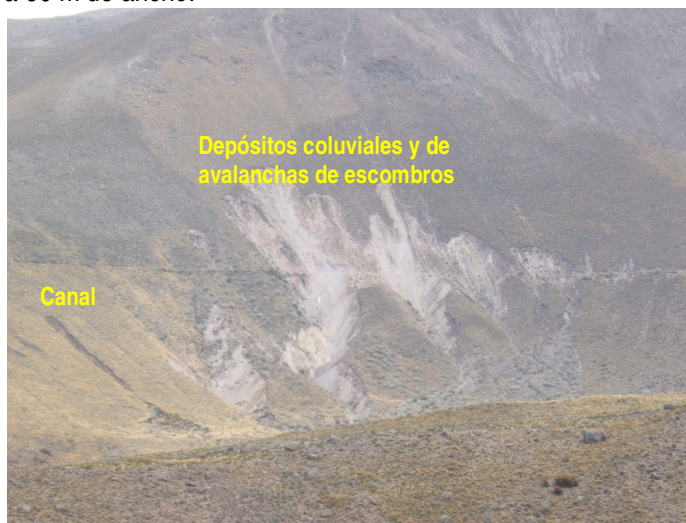
Fig. 3.16: Derrumbes reactivados que afectaron canal de agua, en una zona de fuerte pendiente.
