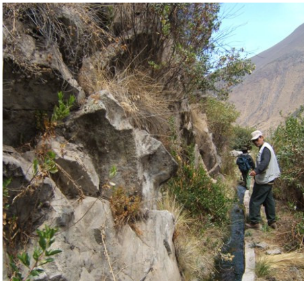
Fig. 3.13: Tramo de canal revestido que no ha sufrido daños, localizado al pie de lavas.
