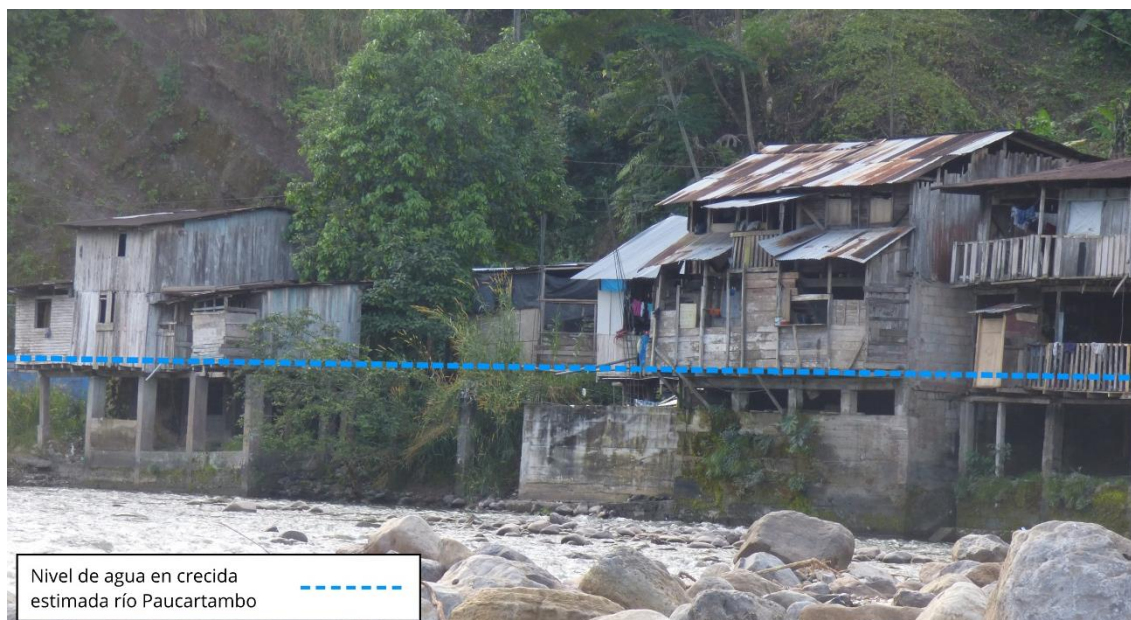
Foto 5. Viviendas expuestas a inundación y erosión fluvial, construidas precariamente en la margen izquierda del río Paucartambo.
