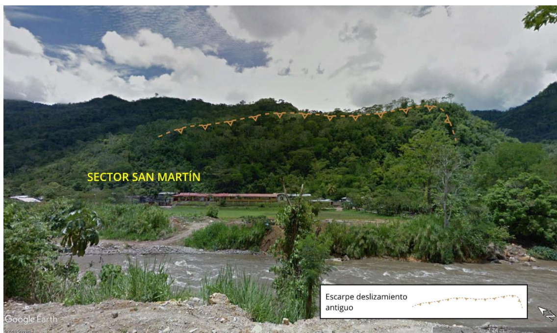
Figura 17. Ladera la ladera este del sector San Martín mostrando rasgos de posibles deslizamientos antiguos. Foto Google Street View 2013.
