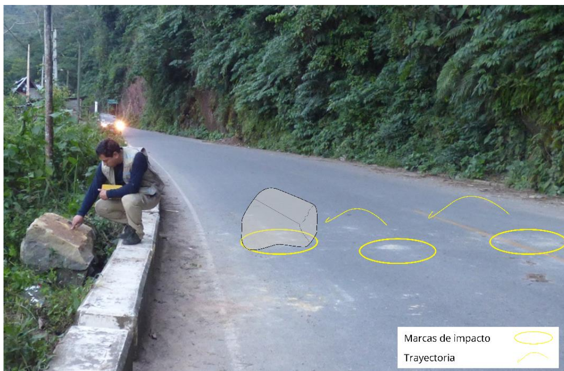
Figura 13. Roca recientemente caída y marcas de impacto en tramo carretero de Puente Paucartambo.
