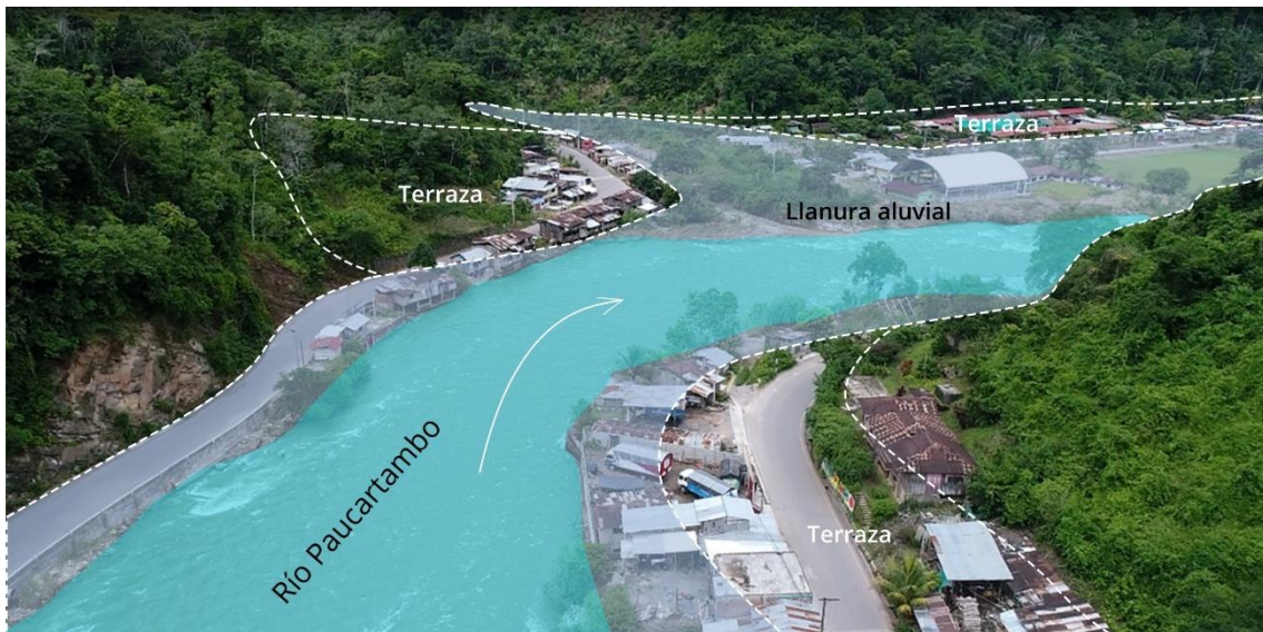
Figura 3. Terrazas y llanura aluvial en la localidad de Puente Paucartambo. Foto INDECI - Villa Rica.
