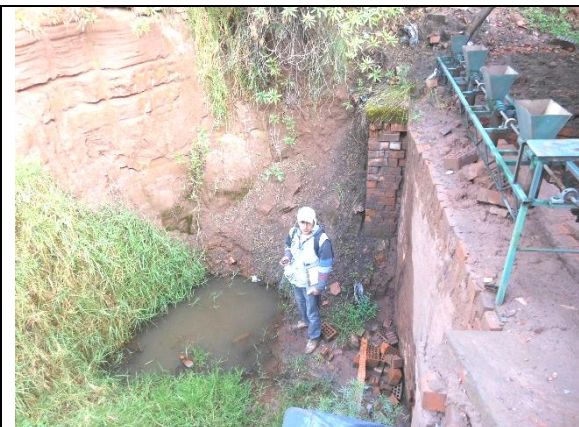
Figura N° 5.3.- Manante ubicado en la ladrillera Sarita Colonia.
