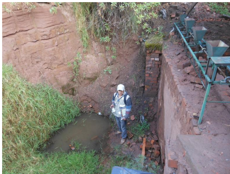
Figura N° 4.30.- Surgencia de agua, ubicado al Oeste de la ladrillera Sarita Colonia. Fuente: Equipo consultor Allin Puriy, 2014.
