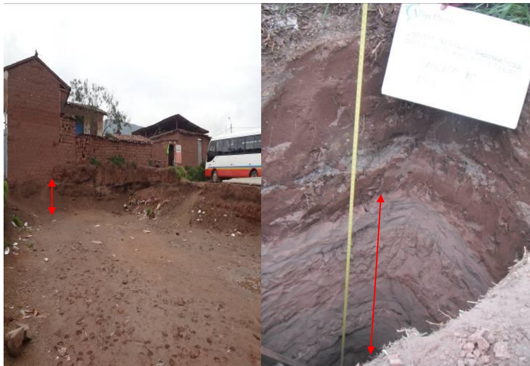
Figura 4.31.- Presencia de estratos de arena, suelos propensos a sufrir licuación.
