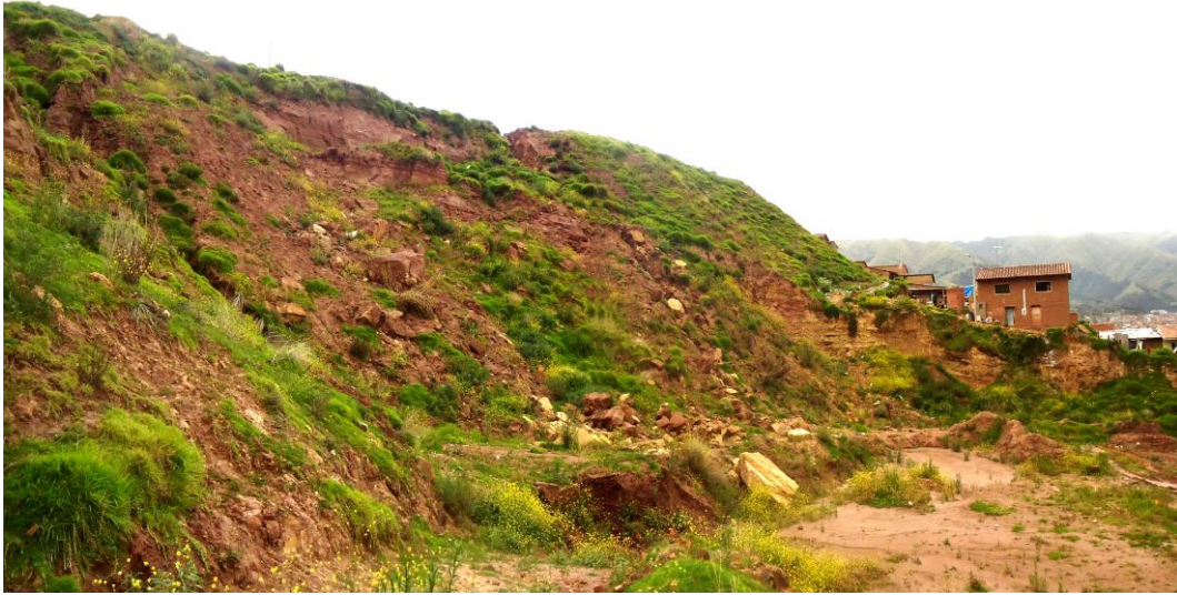
Figura N° 4.10.- Caidas de suelo en la ladrillera Sarita Colonia. Fuente: Equipo consultor Allin Puriy, 2014.
