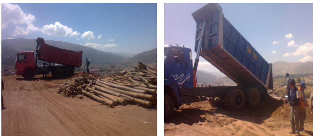
Figura N° 4.5.- Volquetes descargando material de desmonte al Este (parte baja) de la Asociación de Vivienda Altiva Canas
