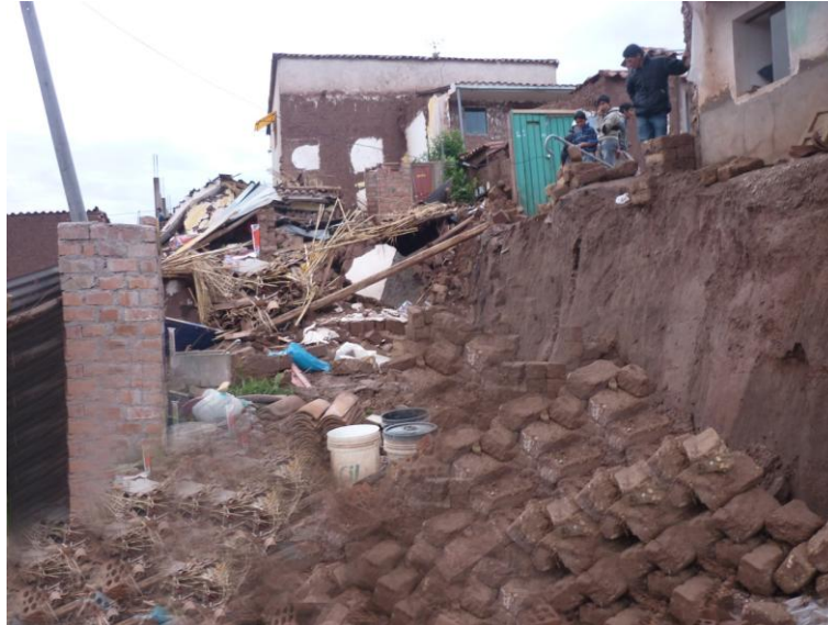
Figura N° 4.7.- Vivienda colapsada el 03 de enero del 2013 a causa del deslizamiento en la Asociación de Vivienda Altiva Canas Mz. S - 9
