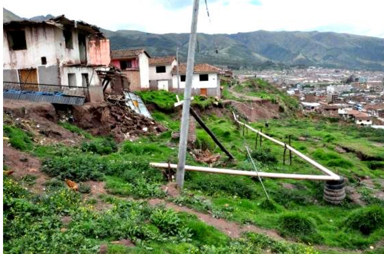
Figura N° 4.40.- Conexión de agua en mal estado altamente vulnerable.
