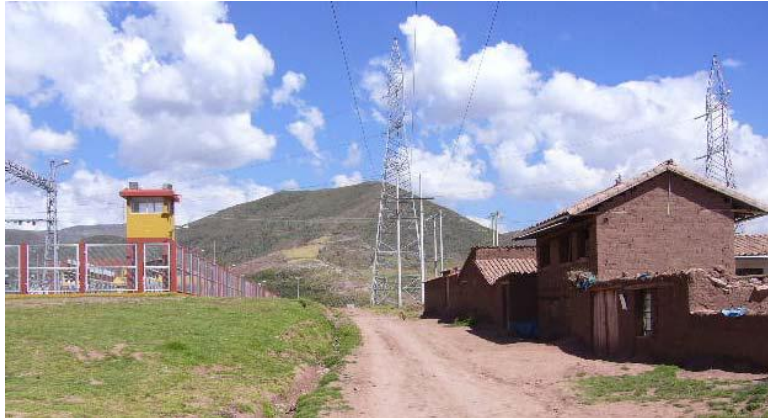
Figura N° 3.6.-Invasión de áreas de servidumbre en líneas de alta y media tensión. Fuente: Equipo consultor Allin Puriy, 2014
